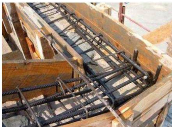
Fig. 3.18 – Detalhe do reforço no topo da cobertura (Penna et al., 2012).
