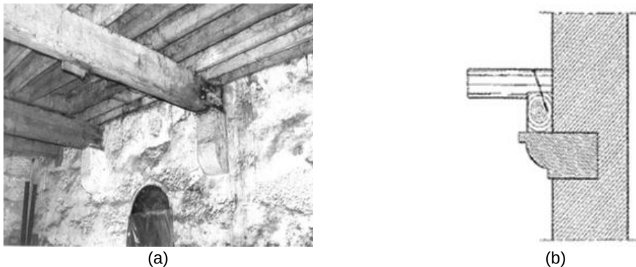
(a) Apoio da viga em cachorro de pedra (Sousa, 2006); (b) apoio do frechal em cachorro de pedra (Leitão, 1896)
