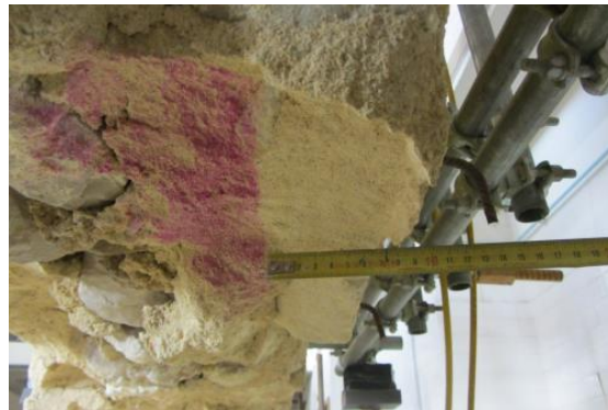
Fig. 4.32 – Medição da profundidade de carbonatação.
