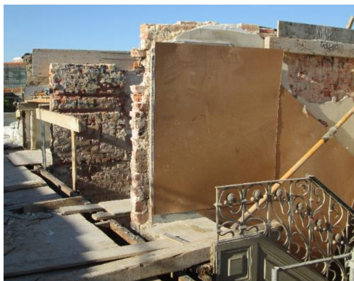
Fig. 3.36 – Paredes de alvenaria de tijolo.
