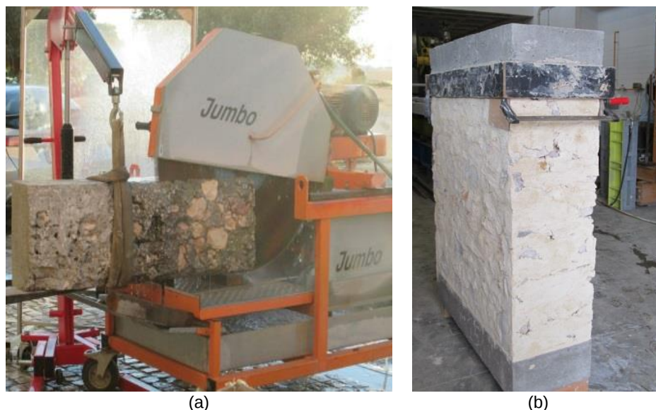
(a) Preparação do lintel pré-existente (regularização de face) para distribuição de cargas verticais; (b) aspeto final do murete
