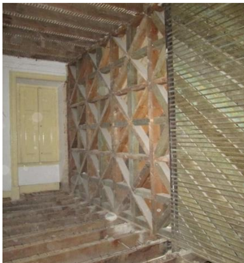
Fig. 3.37 – Paredes interiores de frontal e de tabique.
