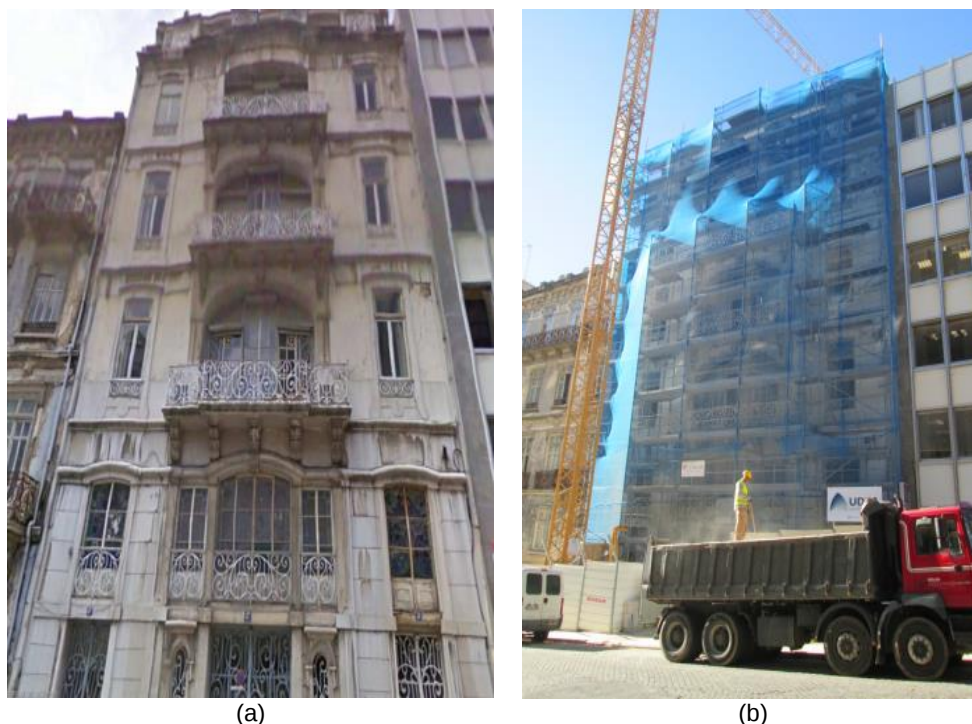
(a) Antes dos trabalhos de reabilitação (A2P); (b) durante a visita à obra
