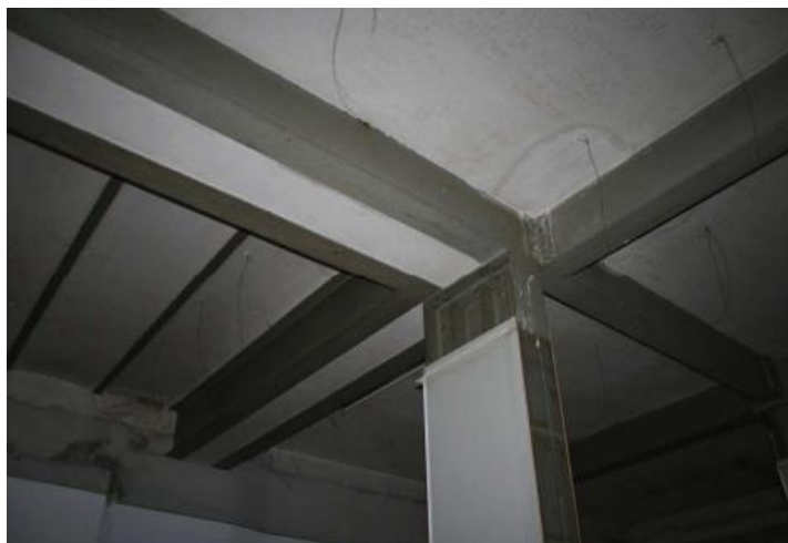
Fig. 3.40 – Apoio das paredes do saguão Sul (A2P).
