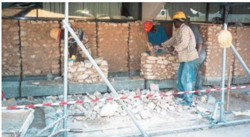
Fig. 3.2 – Construção dos muretes junto ao tardo do Departamento de Engenharia Civil (Pinho, 2007).
