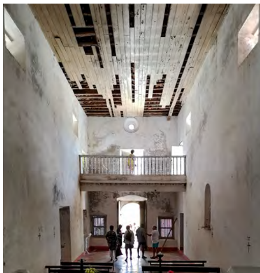
Fig. 18. Cobertura na Igreja de Nossa Senhora dos Remédios, na Cabaceira Grande.
