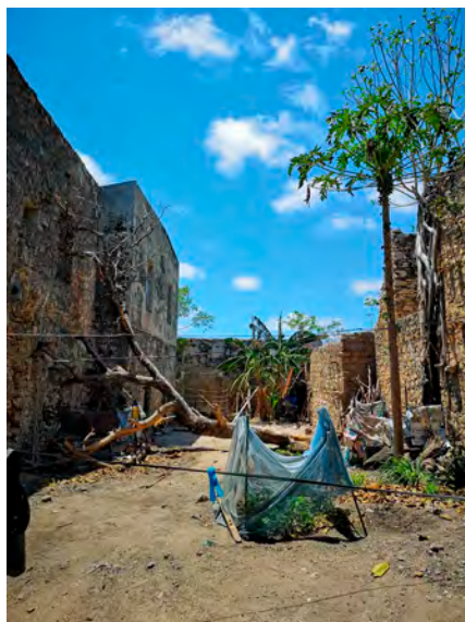
Fig. 9d. Corpo da Igreja do antigo Convento de São Domingos
