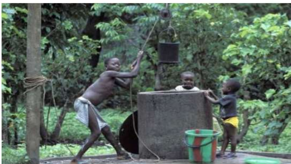
Figura 7- Saída do poço freático protegida com estrutura de concreto.
