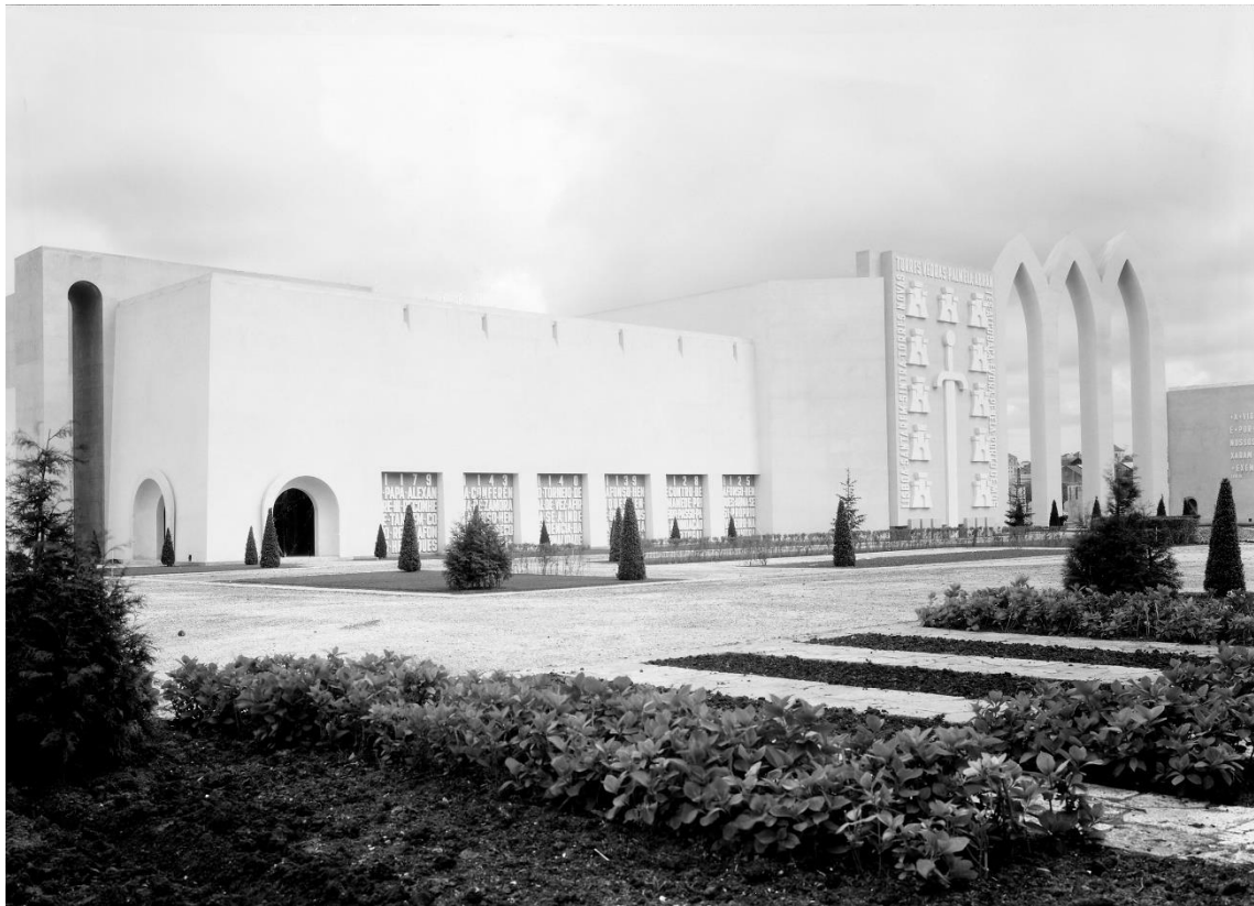
Figures 53 and 54. The Pavilhão da Fundação and the Pavilhão da Formação e Conquista (Pavilion of the Formation and Conquest), both designed by Raul Rodrigues de Lima, at the Exposição do Mundo Português , 1940. Photos by Estúdio Horácio Novais. Col. Estúdio Horácio Novais I FCG – Biblioteca de Arte e Arquivos.
