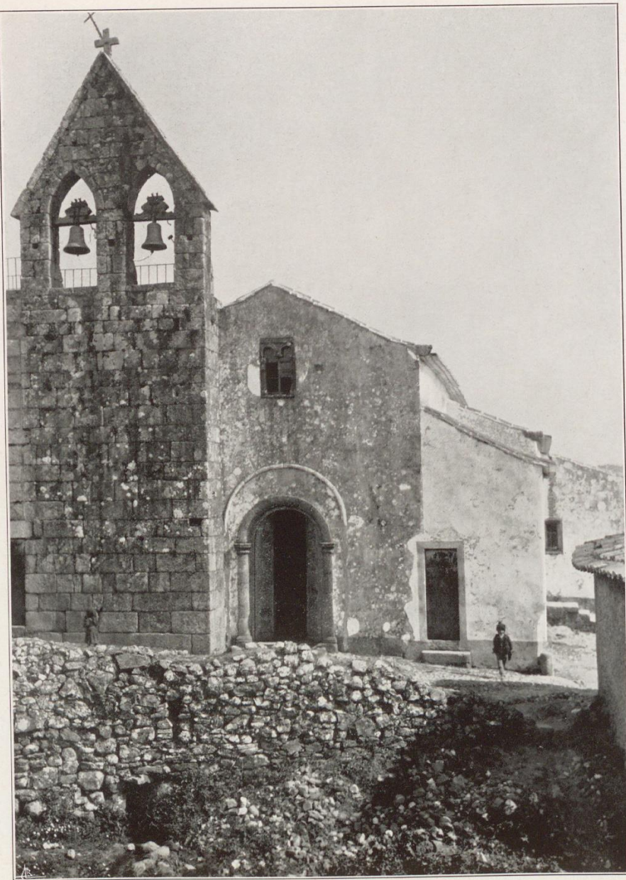
Est. 6 — Igreja de S. Pedro de Lourosa — Fachada principal, com o campanário duplo, século XIII (ao norte), capela de Nossa Senhora da Piedade (em acréscimo à nave lateral do sul) e braço do transepto (ao sul), antes da restauração
