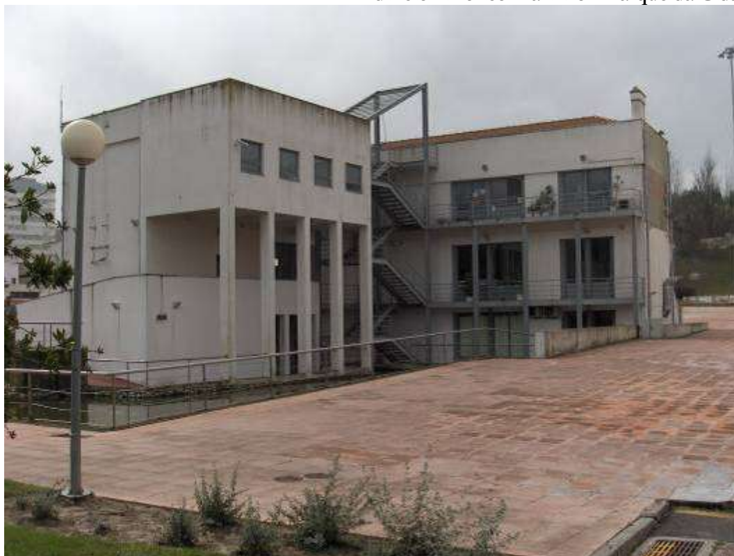
Edifício Américo Marinho – Parque da Cidade.
