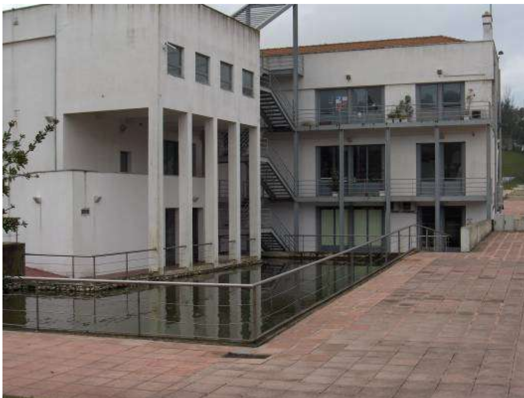
Fotografias 1 e 2 – fachada norte e lago.
