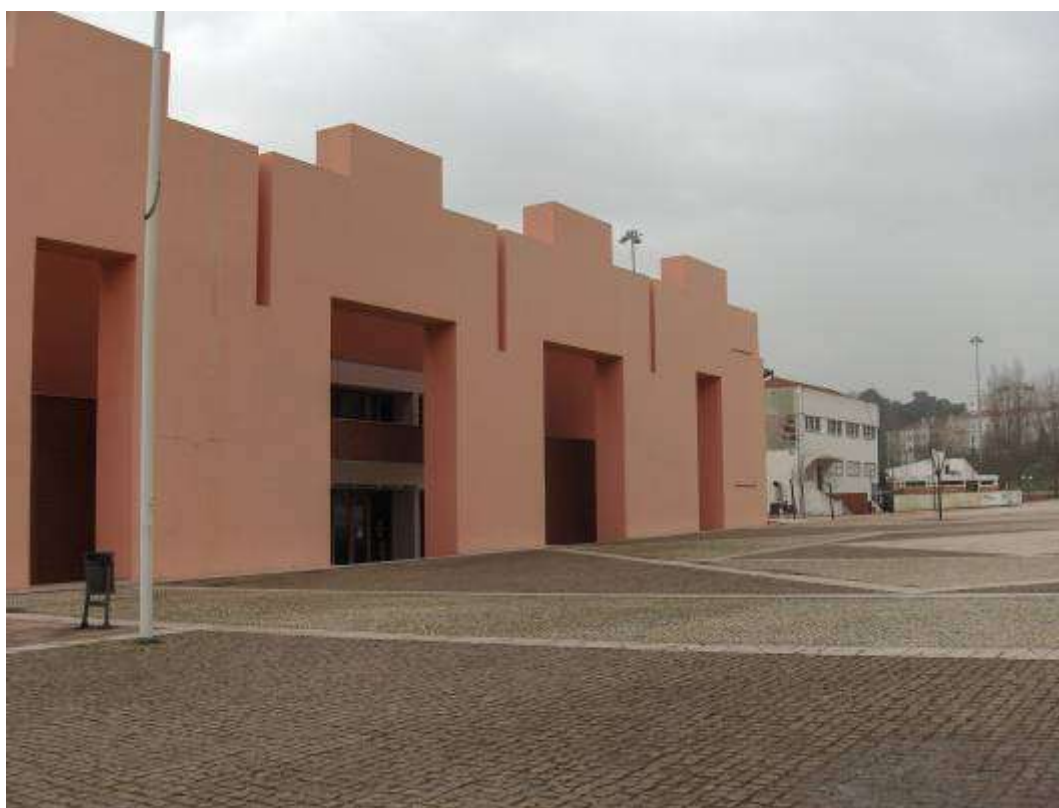
Fotografias 5 e 6 – fachadas norte ( backstage ) e sul (entrada principal).
