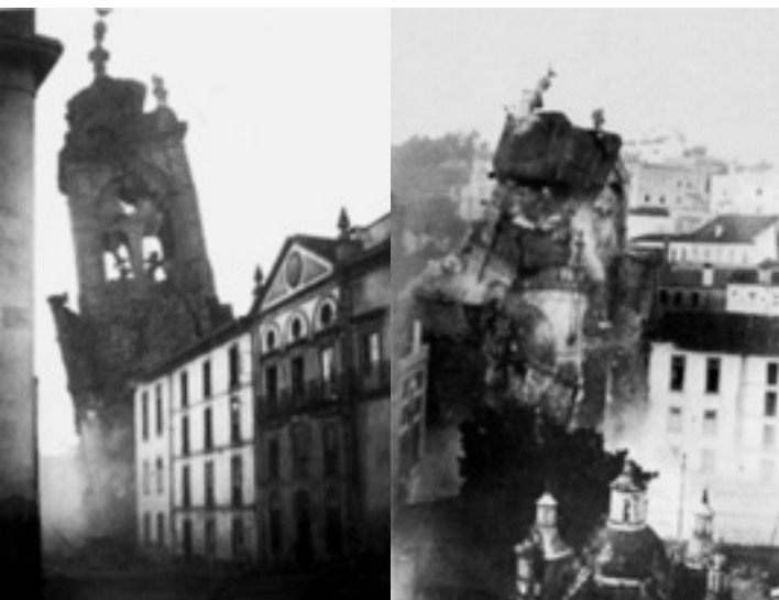
Figs. 9 e 10 – Demolição da torre a 3 de Janeiro de 1935.
