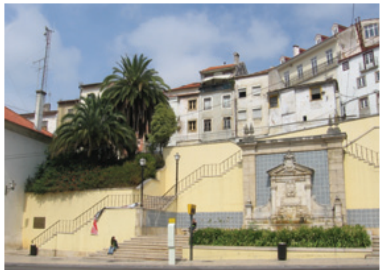
Fig. 11 – Escadório construído em 1986 na actual rua Olímpio Nicolau Rui Fernandes, no lugar da derrocada da torre.
