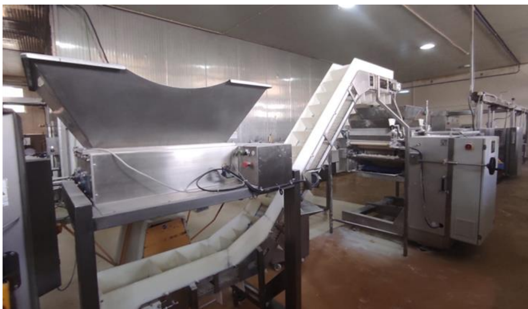
Figura 3.14 - Instalação da Tremonha de alimentação da Extrusora
