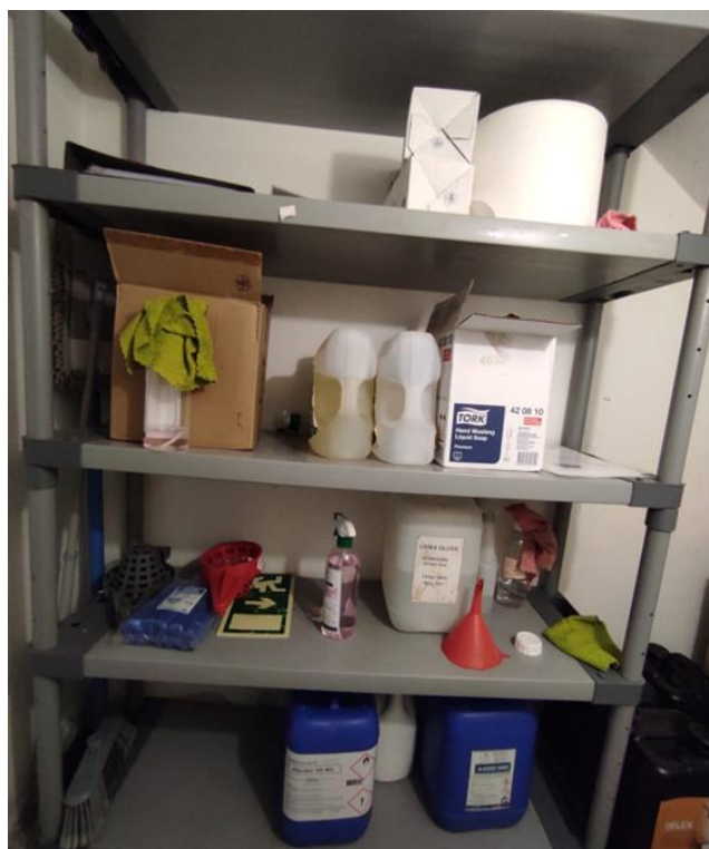
Figura 3.16 - Estado inicial do espaço de arrumação de produtos químicos 2
