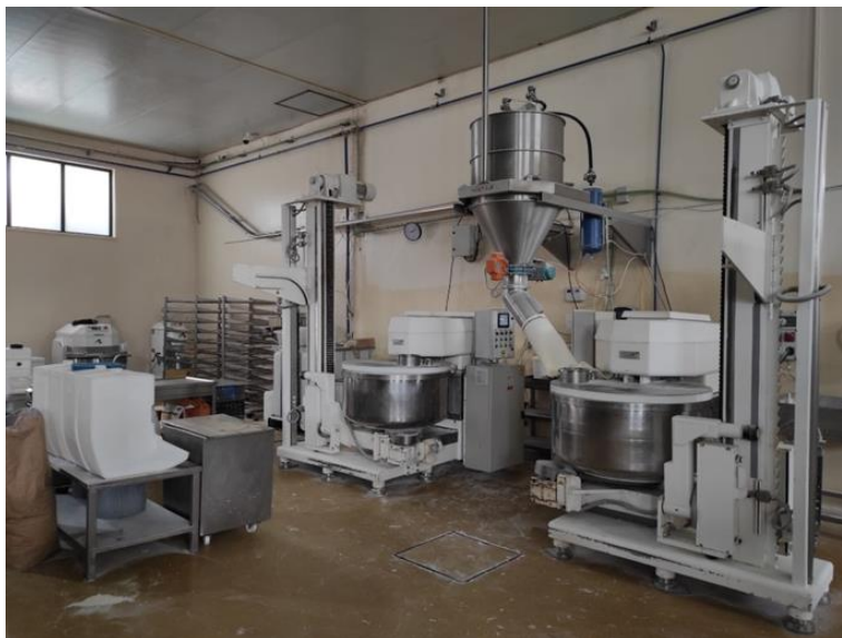
Figura 3.18 - Estado inicial da Amassaria
