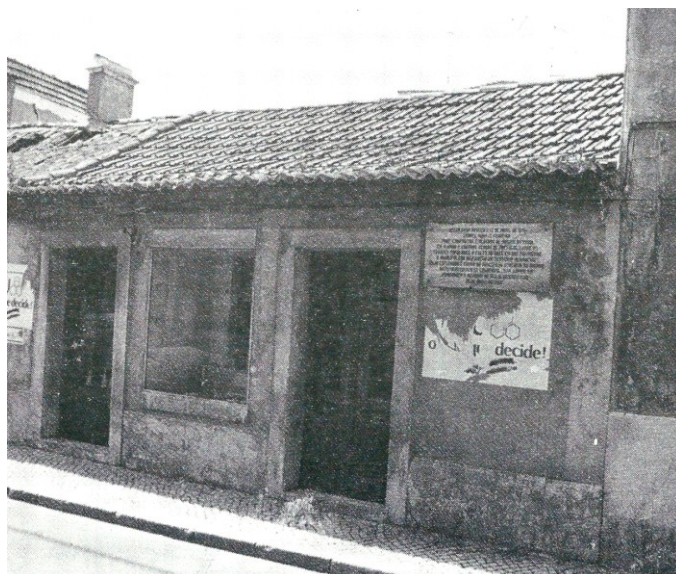
Figura 6: Local de nascimento de Leonel Duarte Ferreira, onde actualmente está em construção (desde Outubro de 2011), por iniciativa da CMA, o futuro Museu da Música Filarmónica. 59
