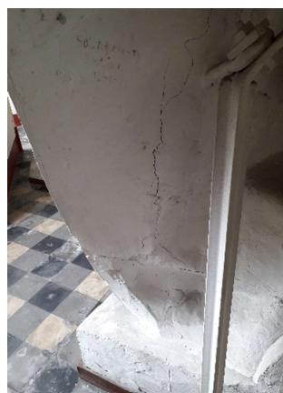
Figura 51 - Pormenor da parte traseira I (Génio da Independência) Fonte: do autor
