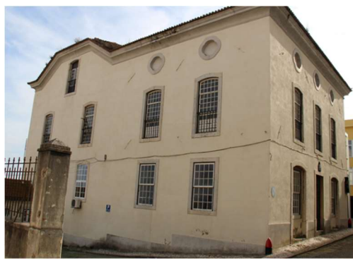
Figura 7- Edifício da Sala dos Gessos Fonte: do autor
