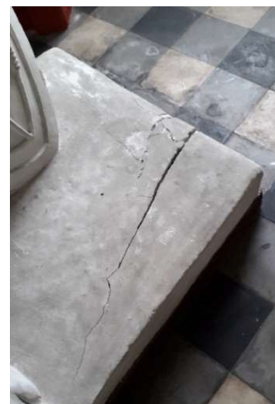
Figura 49 - Pormenor da base I (Génio da Independência) Fonte: do autor
