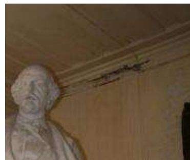
Figura 8- Tecto e paredes da sala Fonte: do autor
