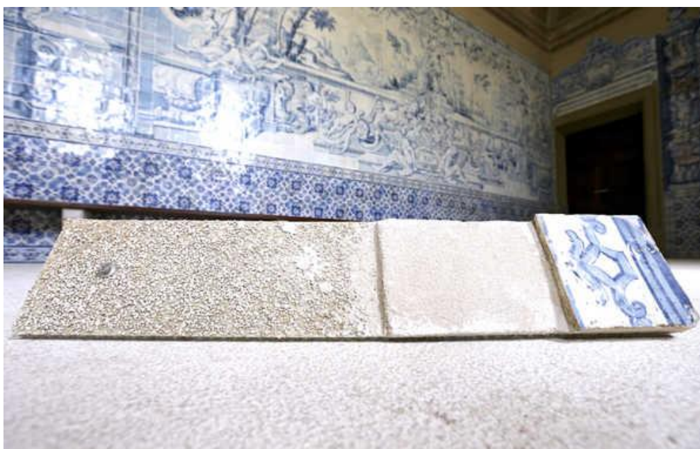
Anexo 12 - Exemplo do processo de colocação dos azulejos na Sala D. Manuel, após o seu restauro
