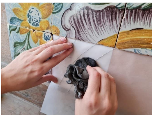
Figura 71 - Transferência do desenho para a chacota vidrada.
