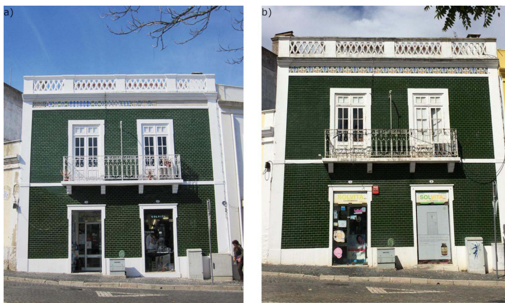
Figura 8. a) aspeto da fachada após a obra; b) aspeto atual da fachada.
