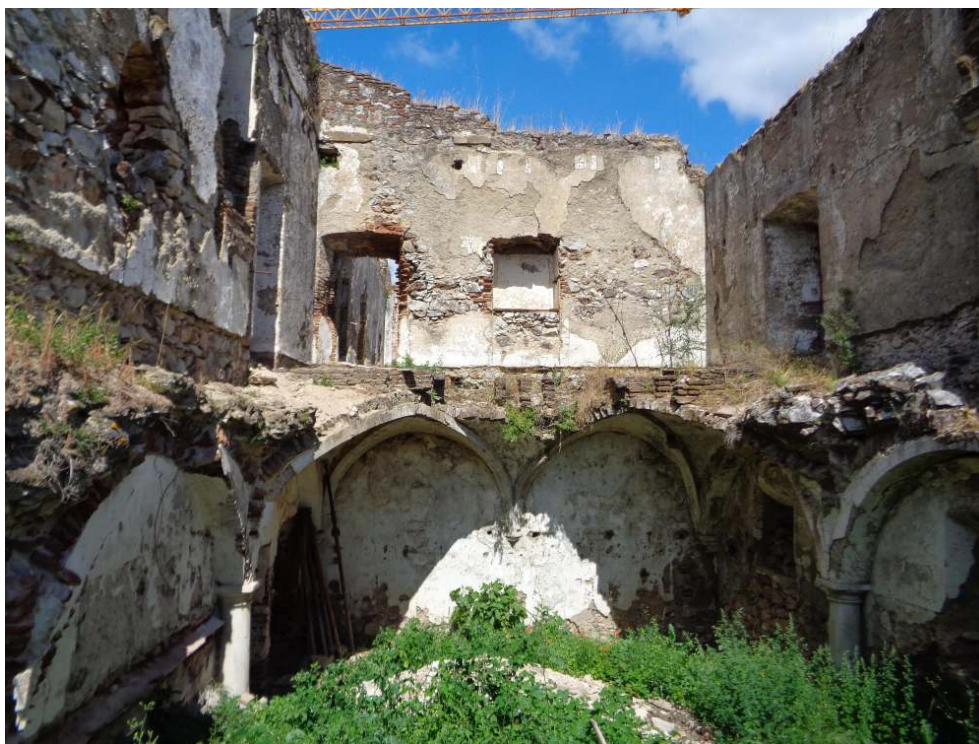
Figura 3. Aspecto de uma das salas da ala NE, em 2018, antes do início das obras.
