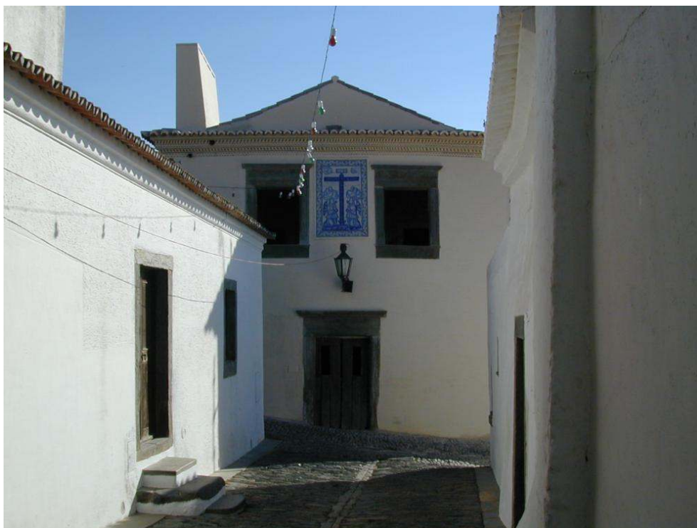
Figura 6. Frontaria da Casa da Inquisição, de Monsaraz, após as obras de reabilitação.
