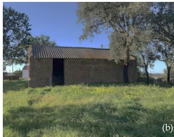
Figura 1.1. Edifício em taipa no Alentejo, Portugal: (a) com reboco exterior, Roncão; (b) São Francisco da Serra
