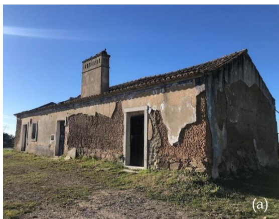
Figura 1.1. Edifício em taipa no Alentejo, Portugal: (a) com reboco exterior, Roncão; (b) São Francisco da Serra
