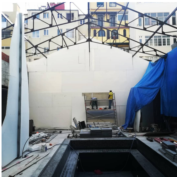
Figura 4.41 – Colocação das placas impermeáveis da parede viva no Hotel Hotel Fonte: Workin Garden
