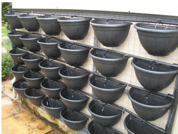
Figura 3.21 – Sistema de irrigação por gotejamento em parede viva modular por vasos
