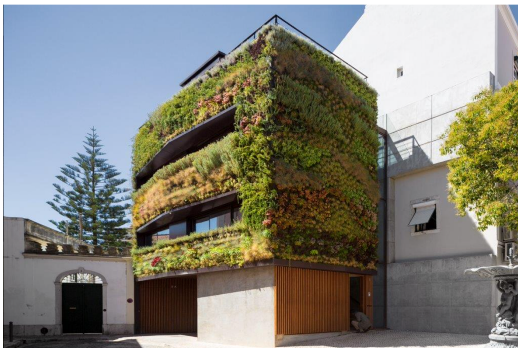
Figura 4.2 – Parede verde da moradia da Travessa do Patrocínio
