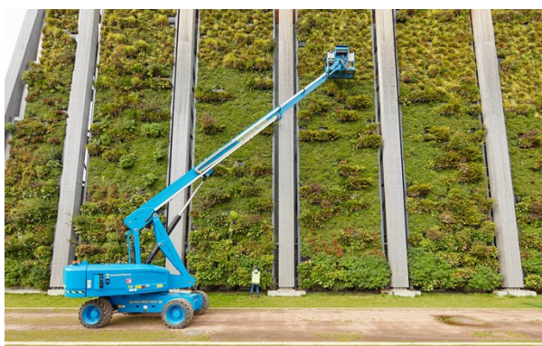
Figura 3.25 – Manutenção de uma parede viva através de dispositivo de elevação
