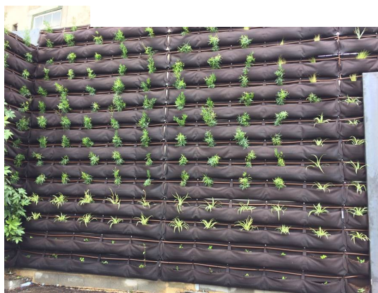
Figura 4.20 – Sistema de bolsas TERRAWALLY utilizado na parede viva no A Valenciana
