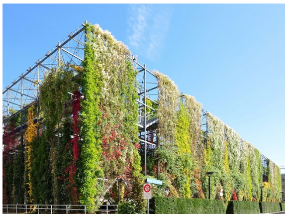
Figura 3.36 – Fachada verde em MFO Park Switzerland Fonte: Google Imagens, obtido a 23 setembro 2021
