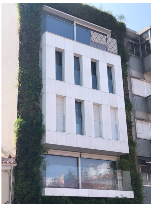
Figura 4.15 – Parede viva contínua do edifício em estudo
