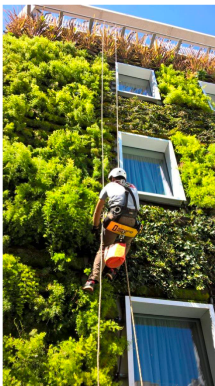
Figura 4.12 – Operação de manutenção da parede viva do Bessa Hotel Liberdade Fonte: Terracell
