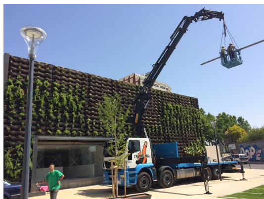
Figura 4.21 – Fase final da instalação da parede viva no A Valenciana
