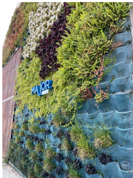
Figura 4.30 – Pormenor da tela absorvente da parede viva do Atelier Sidney Quintela
