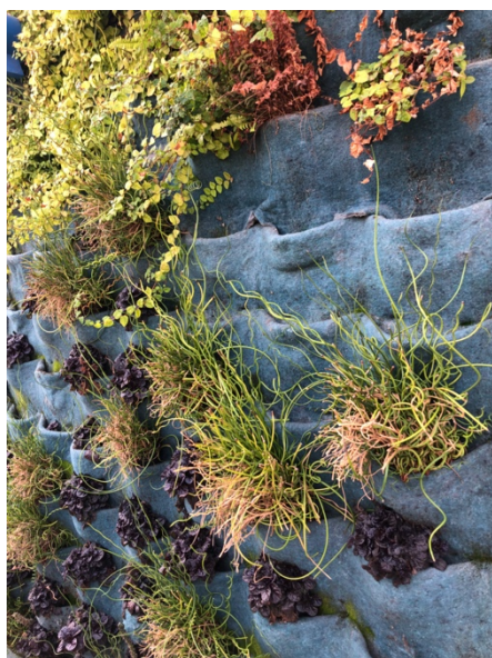
Figura 4.33 – Bolsas, da tela absorvente, vazias na parede viva do Atelier Sidney Quintela
