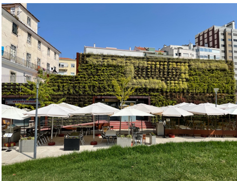
Figura 4.18 – Fachada principal com parede viva em A Valenciana
