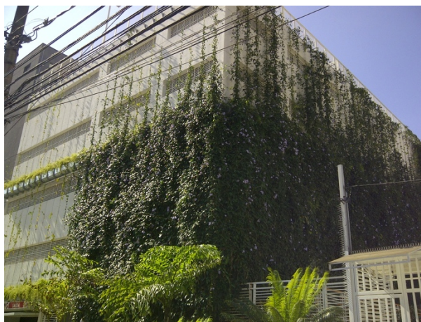
Figura 3.10 – Exemplo real de fachada verde indireta com sistema de rede de cabos Fonte: Google Images, obtido a 21 junho 2021
