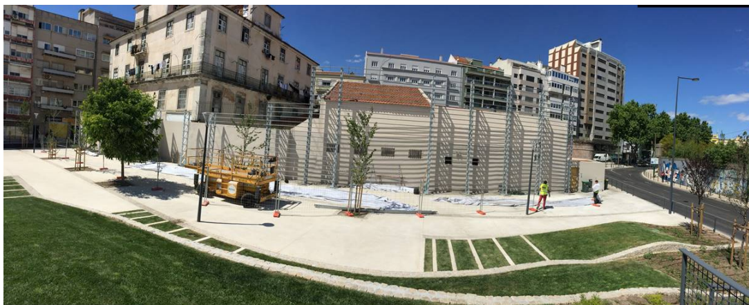
Figura 4.19 – Estrutura metálica instalada como suporte para a parede viva do A Valenciana
