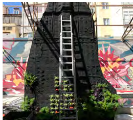
Figura 3.18 – Exemplo de parede verde modular com sacos flexíveis
