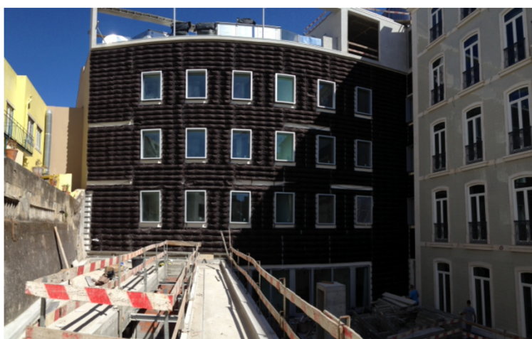
Figura 4.10 – Fase de instalação dos sacos TERRAWALLY na parede do
