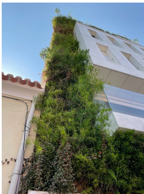
Figura 4.16 – Variedade de espécies de plantas na parede viva do edifício habitacional da Rua Dr. Antônio Cândido
