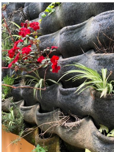
Figura 3.17 – Detalhe dos bolsos flexíveis na camada de feltro
