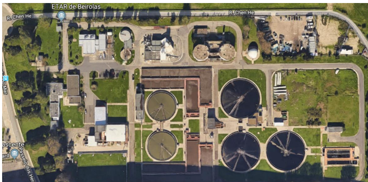
Figura 3.1 – Vista aérea das instalações da ETAR de Beirolas (Google maps: acessido em 5/8/2019).
