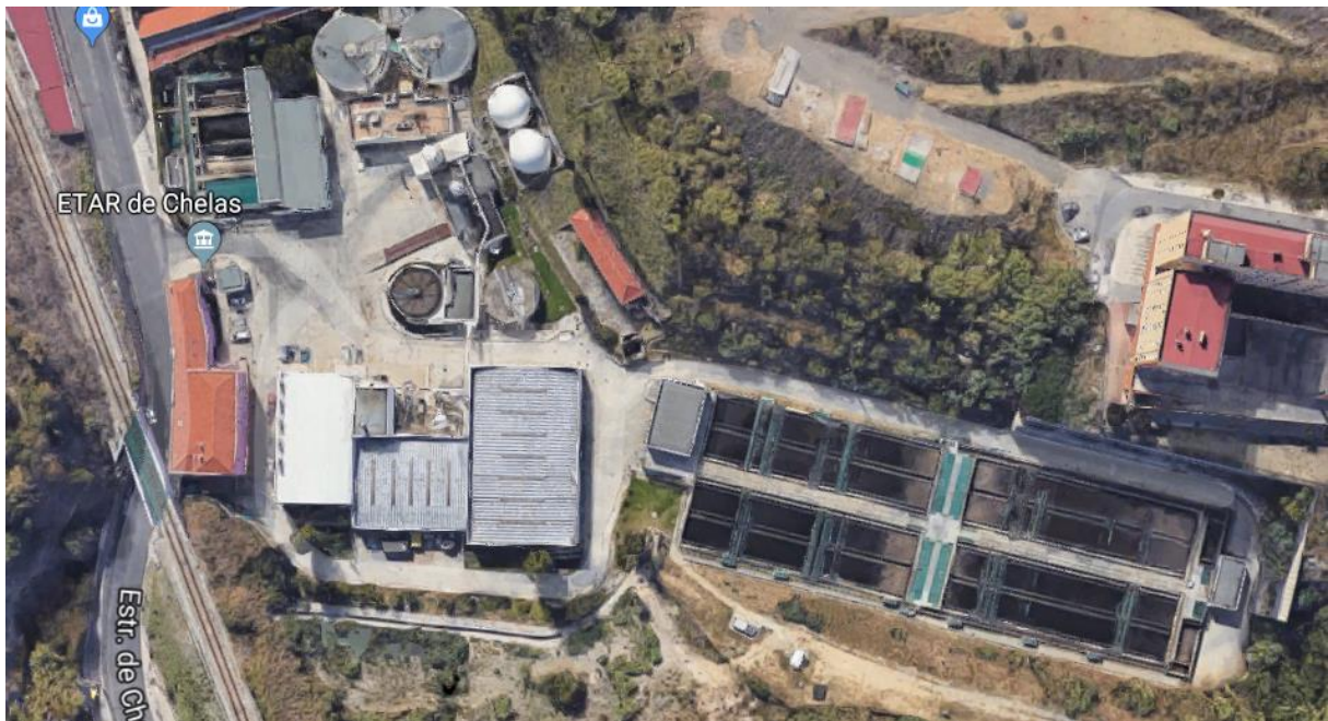
Figura 3.5 – Vista aérea da ETAR de Chelas (Google maps: acedido em 29/8/2019).
