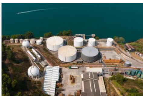
Figura 5.13. Reservatórios do Terminal
