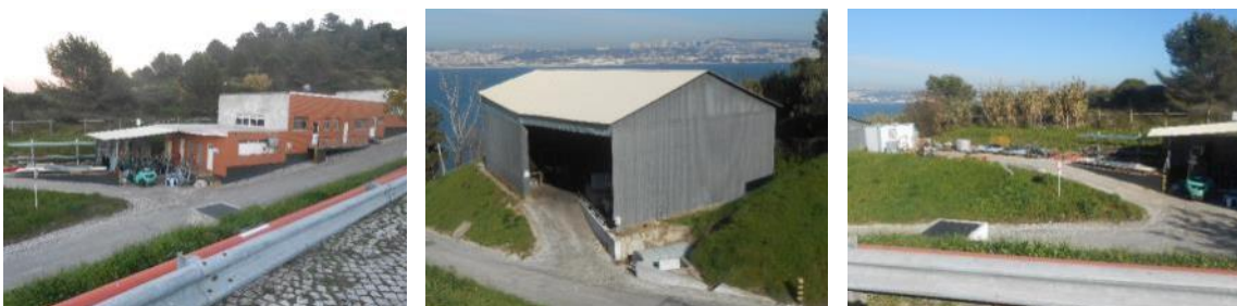
Figura 6.1. Armazém, Oficina e Ferramentaria de Apoio à Manutenção
