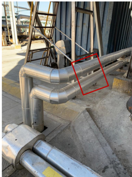
Figura 5.5: Tubagem onde se fará a picagem para encaminhar o óleo em direção ao evaporador do módulo
