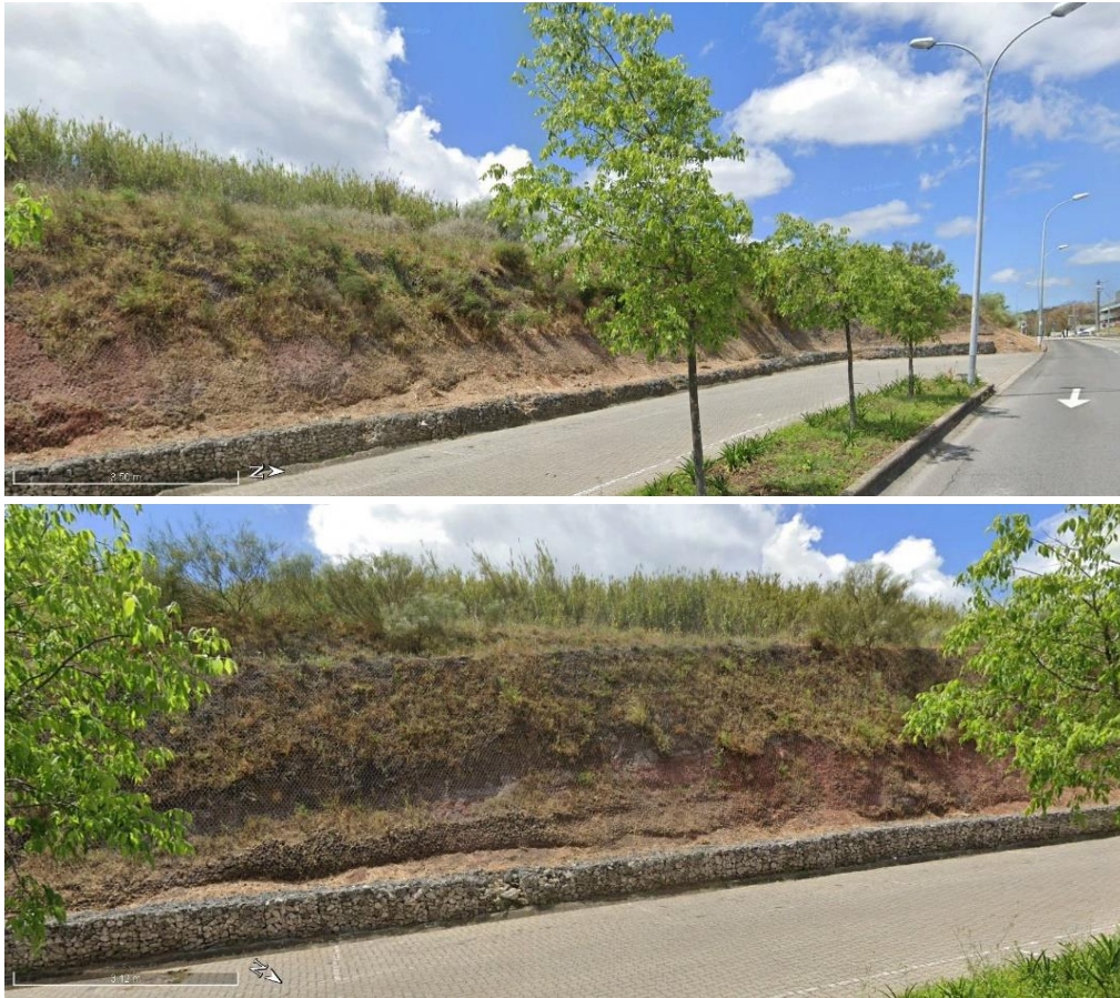
Figura 4.20 - Vista geral do Afloramento do ponto 6, retirado do Google Earth
