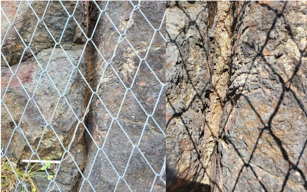
Figura 4.17 - Fraturas subverticais com enchimento no ponto 3
