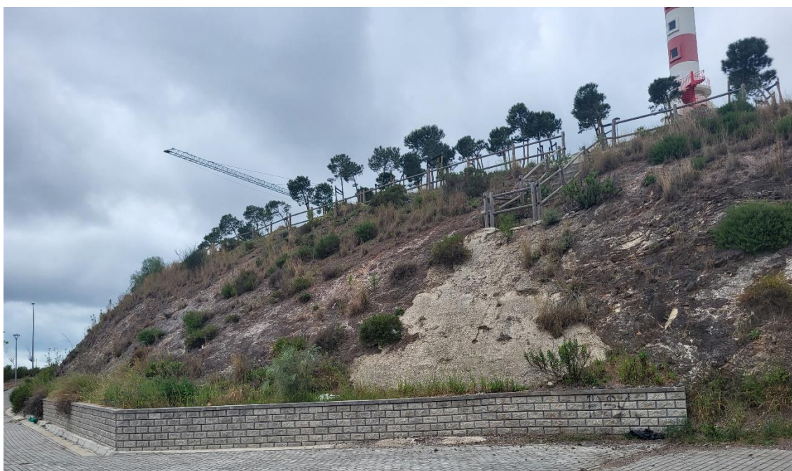
Figura 4.38 - Vista geral do afloramento do Farol da Mama Sul
