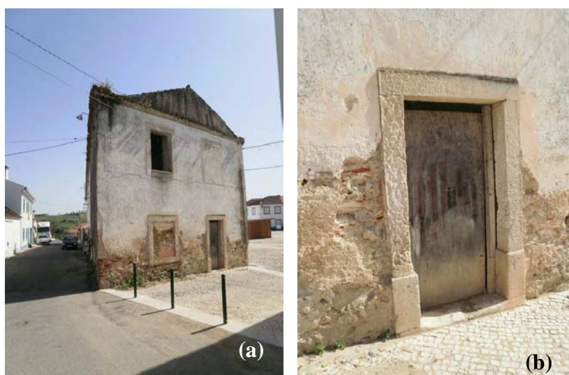
(a) - Fachada lateral; (b) - Pormenor da parede
