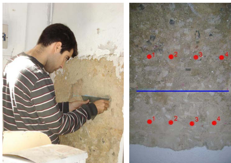
Fig.6.7 – Marcação da ranhura e dos alinhamentos verticais
