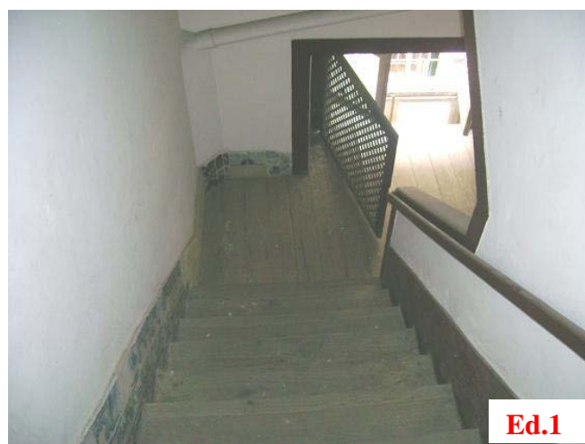
Fig.4.28 – Escada com topos recortados em forma de balaustrada
