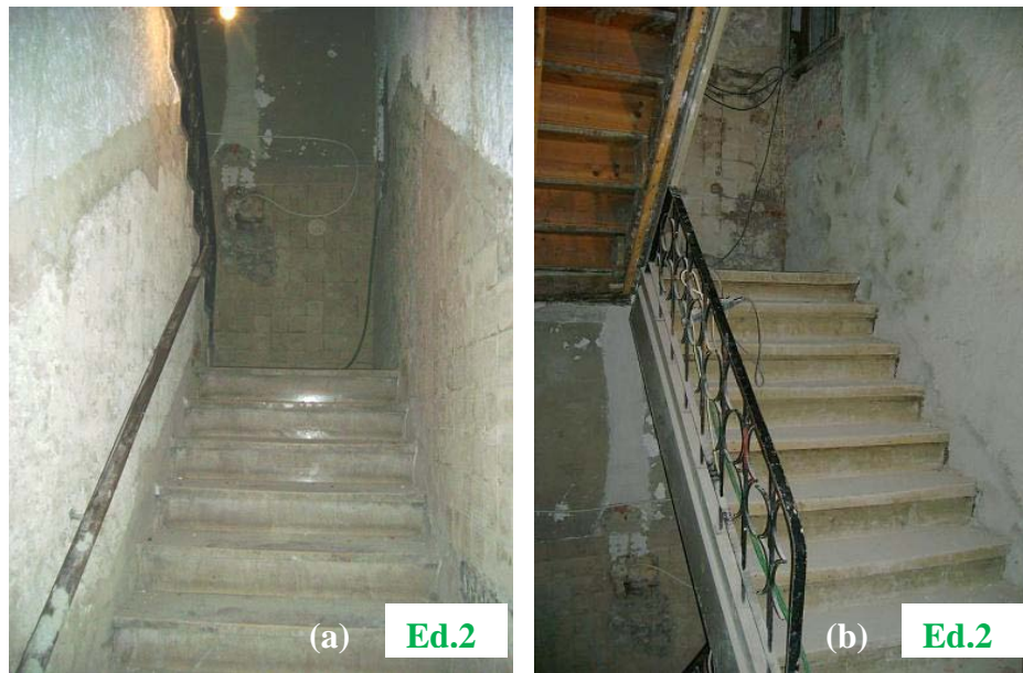
(a) - Primeiro lanço de escada em pedra; (b) - Escadas em madeira de acesso ao 2º piso
