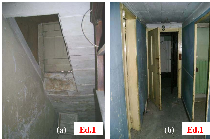
(a) - Perspectiva interior de uma trapeira; (b) - Perspectiva interior da cobertura
