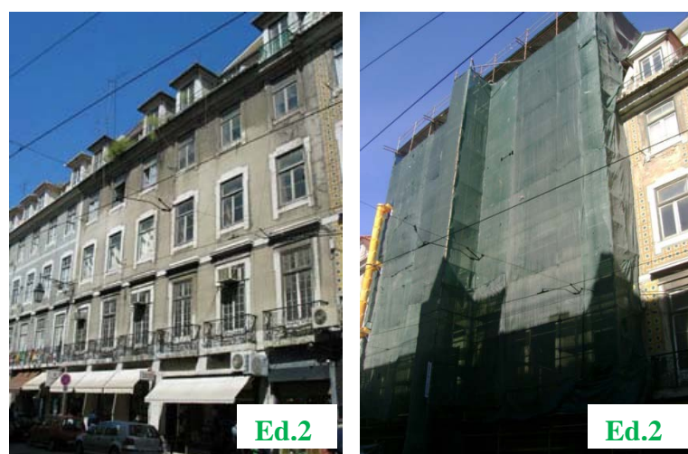
Fig.4.2 – Perspectiva da fachada do edifício 2
