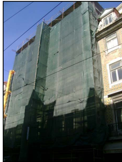
Durante a obra
