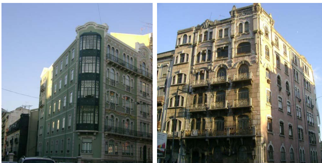
Fig.2.7 – Edifícios “Gaioleiros” localizados na Avenida Duque de Loulé (Lisboa)
