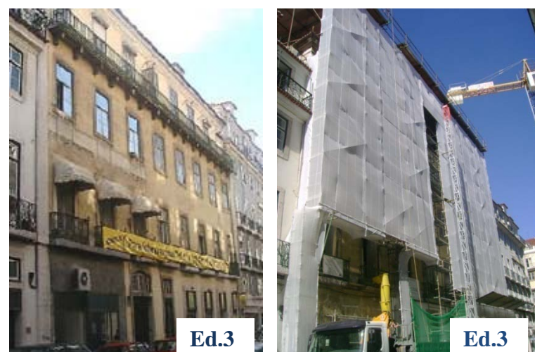
Fig.4.3 – Perspectiva da fachada do edifício 3
