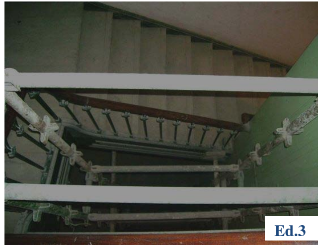
Fig.4.29 – Escada com desenvolvimento em redor de uma bomba
