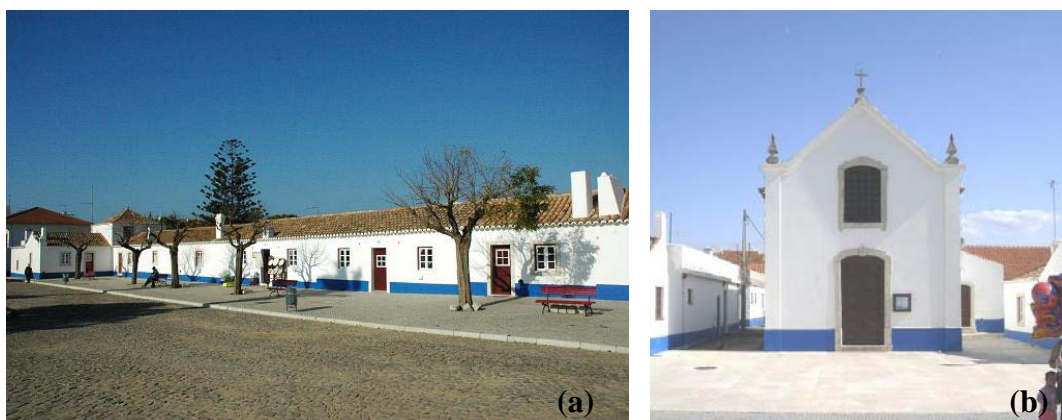
(a) - Continuidade do soco e do beiral ; (b) - Igreja
