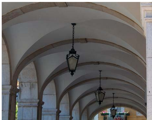
Fig.4.13 – Abóbadas dos edifícios da Praça do Comércio
