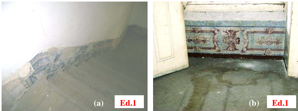
(a) - Lanço de escada; (b) - Patamar de escada
