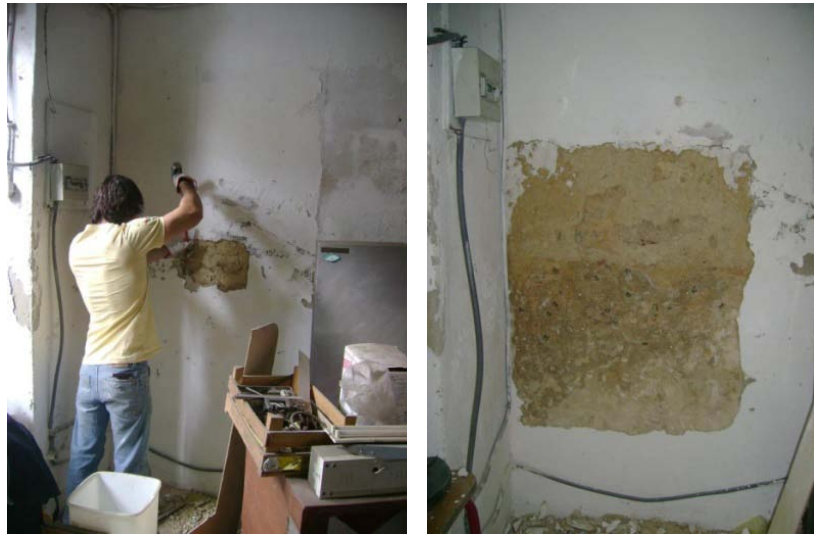
Fig.6.6 – Janela de observação da constituição da alvenaria
