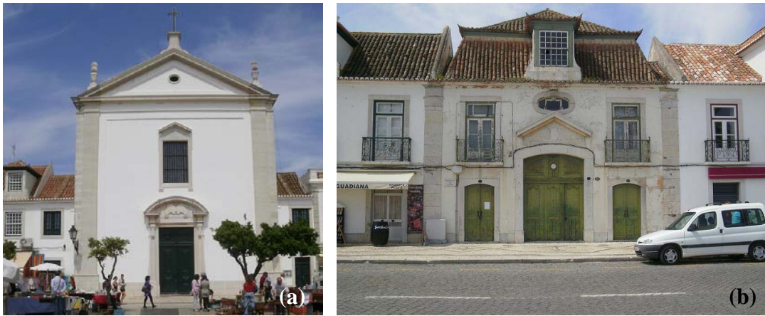
(a) – Igreja; (b) - Edifício da alfândega
