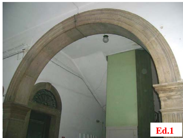
Fig.4.14 – Arco em pedra de um edifício Pombalino observado na Rua Ivens
