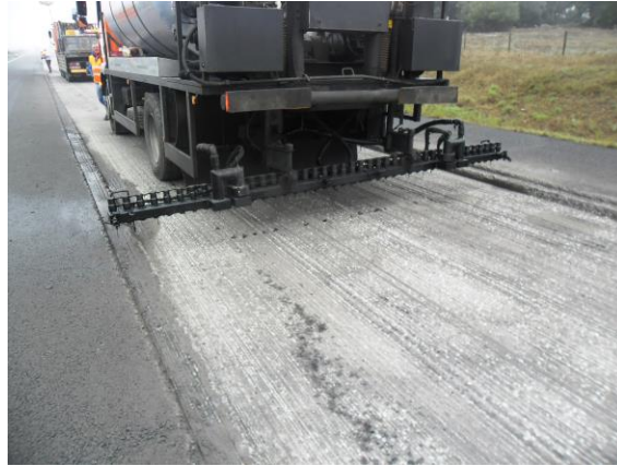
Figura 3.8 - Aplicação da rega de colagem, por meio de barra espargidora
