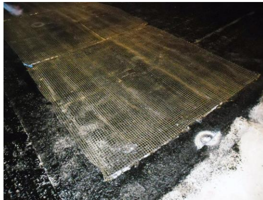
Figura 3.2 - Grelha de fibra de carbono aplicada no pavimento da obra A
