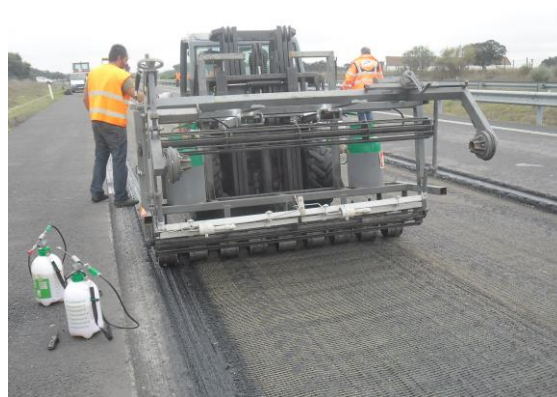
Figura 3.10 - Passagem com o cilindro para promover a aderência entre a grelha de fibra de vidro e a emulsão betuminosa aplicada
