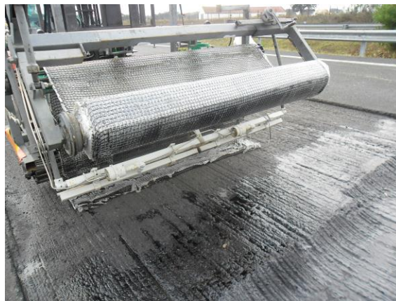
Figura 3.9 - Aplicação da grelha de reforço em fibra de vidro
