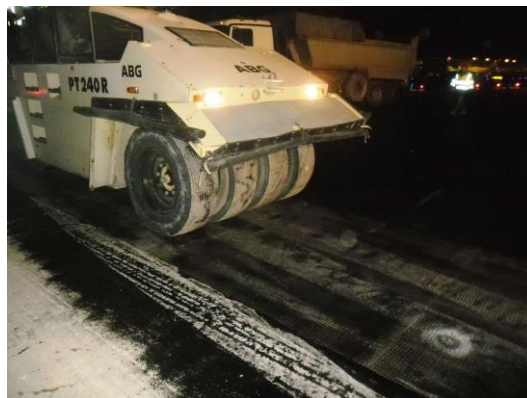
Figura 3.3 - Passagem com o cilindro para promover a perfeita adesão da grelha de fibra de carbono à camada de base inferior da obra A
