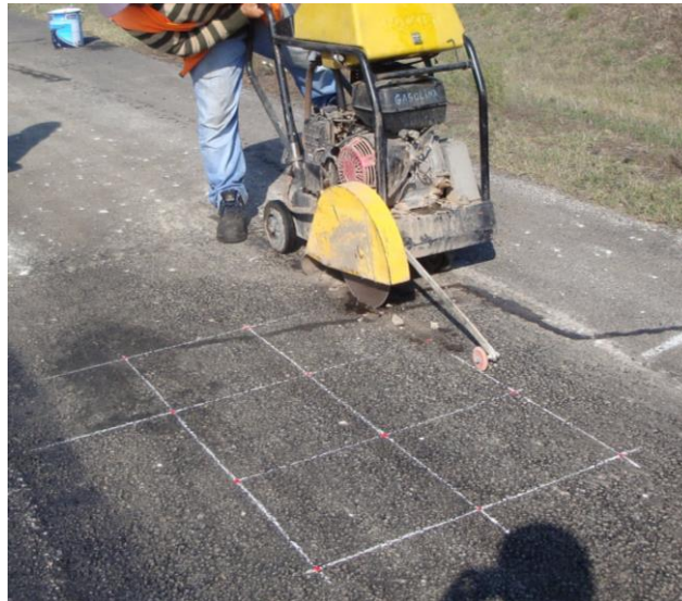
Figura 3.23 - Recolha de lajetas em obra para ensaio Pull-off
