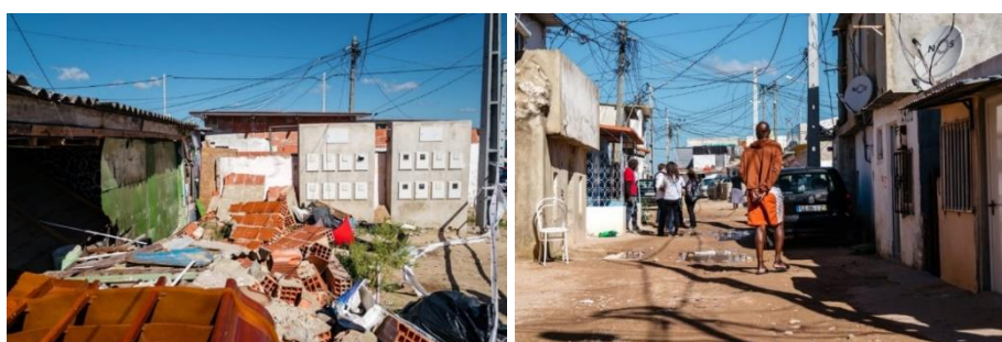
Img. 14 e 15: Demolições realizadas em setembro de 2022. Segundo Torrão: moradores em desespero por situação de desalojamento iminente - Amnistia Internacional Portugal . Acesso em: 20/08/2023
