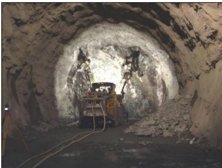
Figura 3.5. Furação para colocação de explosivos (Drill & Blast) nos túneis de adução do circuito hidráulico
