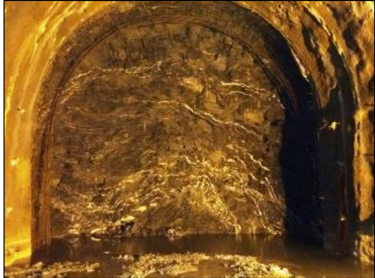
Figura 3.48. Aspecto da litologia encontrada durante a escavação: filitos com intercalações de quartzo
