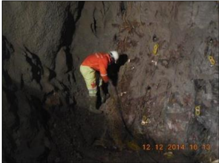
Figura 3.33. Túnel T1C. PK 0+86. Carregamento dos furos com explosivos (emulsão)
