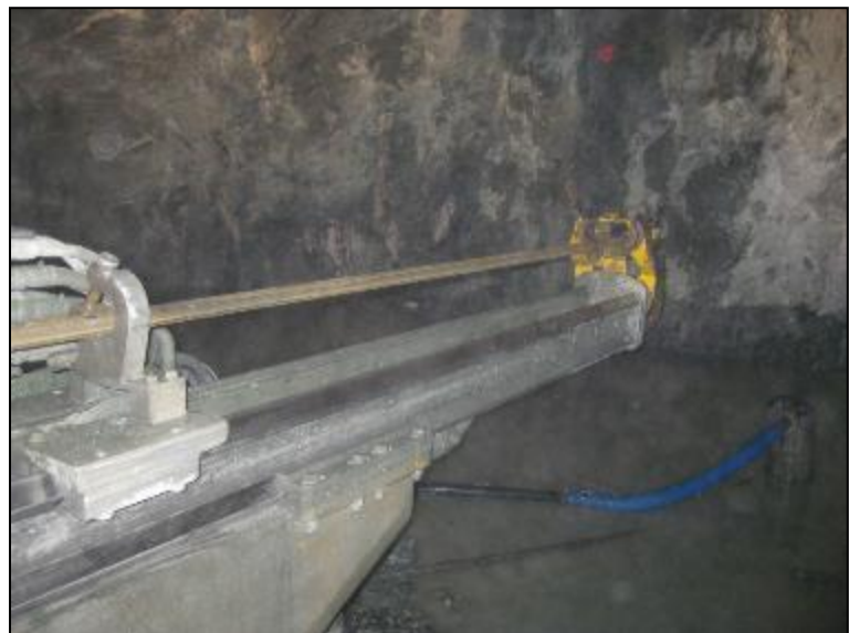
Figura 3.14 Execução do furo exploratório com recurso à ferramenta do jumbo
