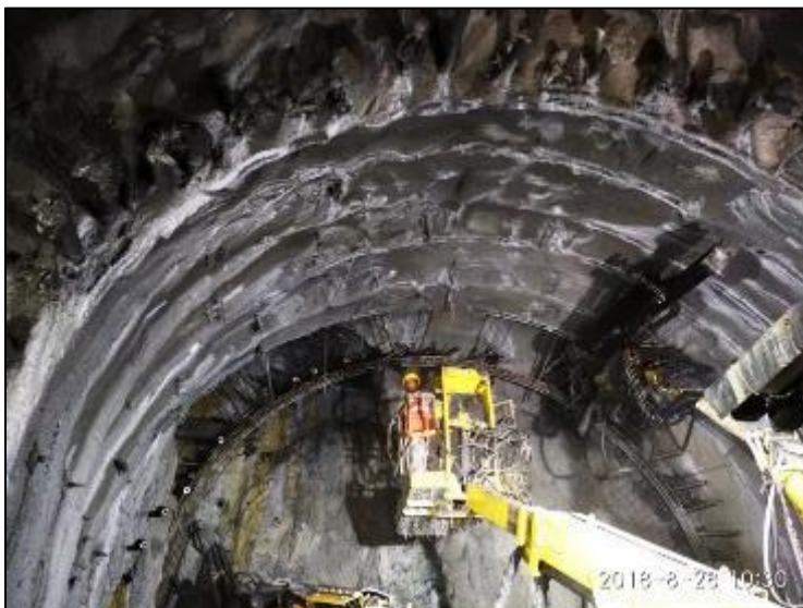
Figura 3.46. Escavação do túnel principal em classe B1
