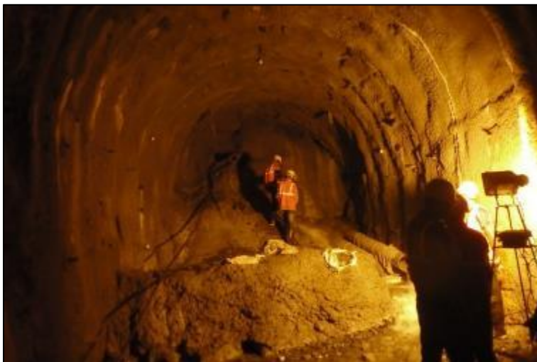
Figura 3.52. Reforço da frente com escombros e betão projectado
