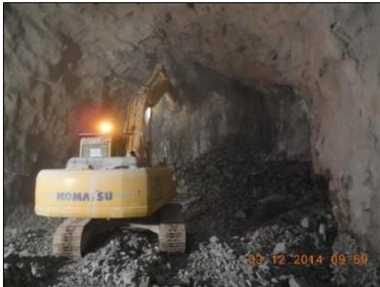
Figura 3.34. Túnel T2C. Operação de saneamento mecânico
