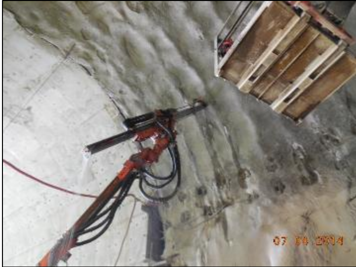
Figura 3.38. Furação para injeções de impermeabilização nos túneis de desvio
