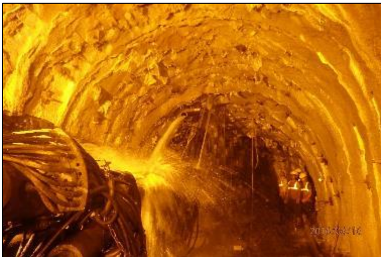
Figura 3.54. Drenagem da frente
