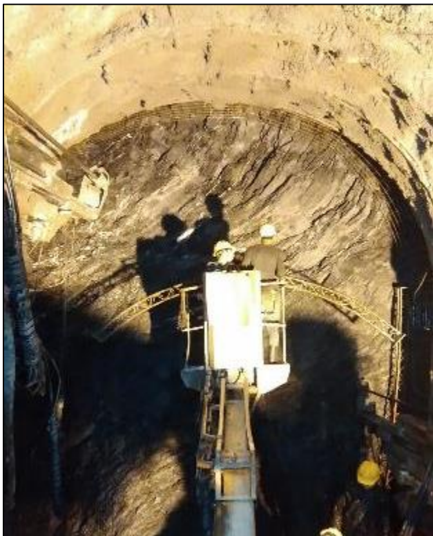
Figura 3.49. Instalação de lattice girder no túnel de serviço
