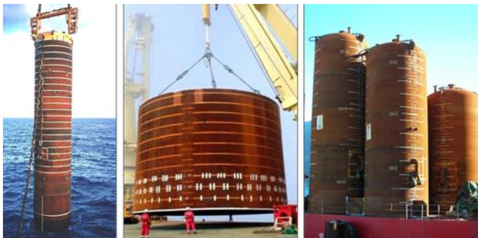
Figura 2.18 – Imagens de estacas de sucção (ngi, 2014, online )
