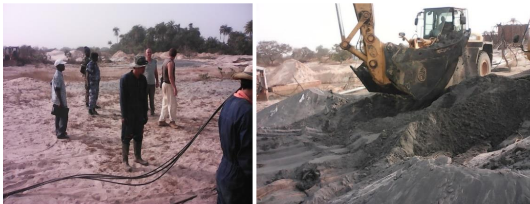
Figura 4.2 Vista da exploração mineira e escavação de areias com uma giratória.
