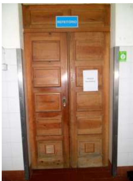
Figura 3.3.- Porta do Refeitório
