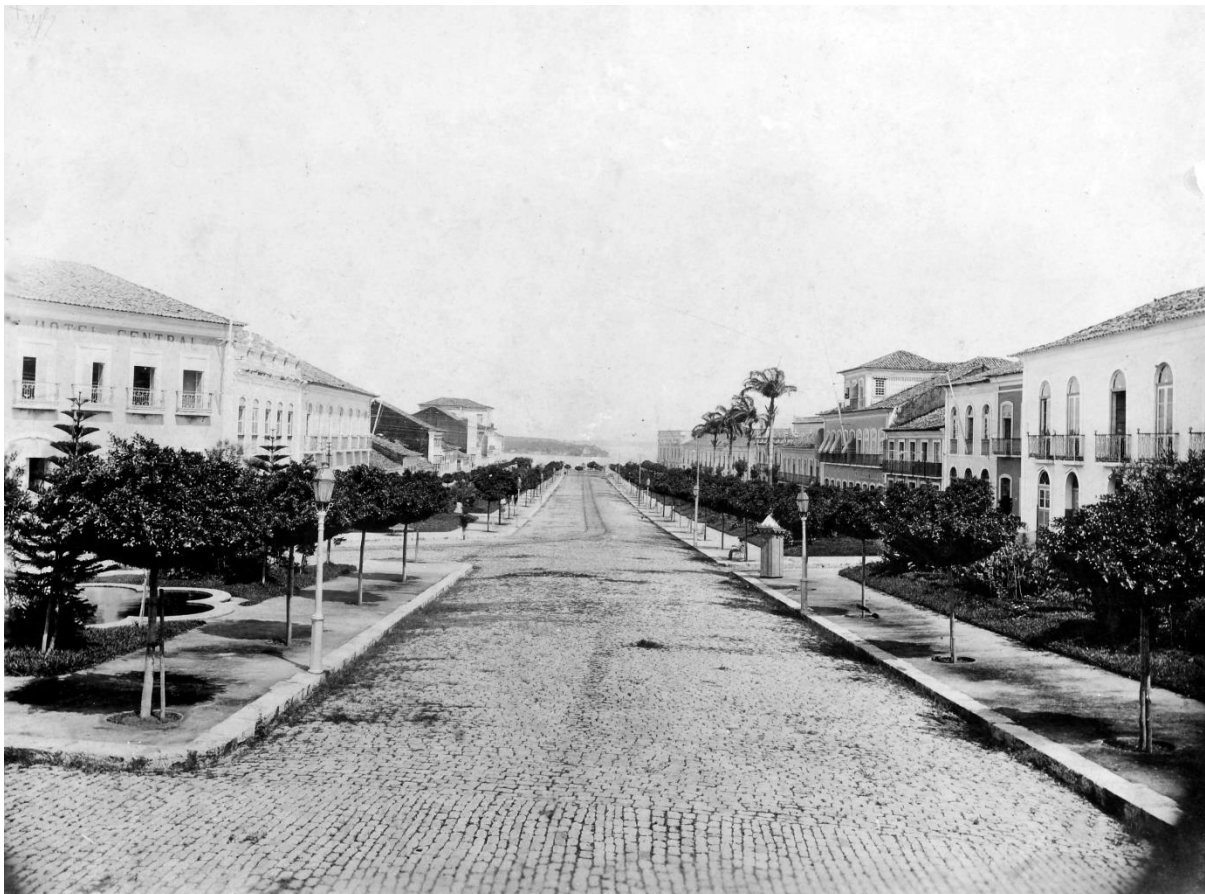
FIGURA 52: Avenida Maranhense, São Luís.
