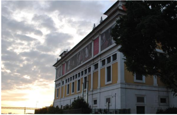
Figura 5.10: Fachada sul – zona do anexo.
