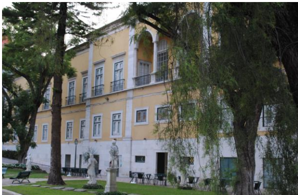
Figura 5.12: Fachada sul- zona do palácio.
