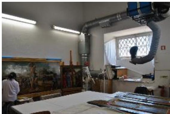
Figura 5.35: Sala de conservação de pintura, piso -1 (vista NW-SE).
