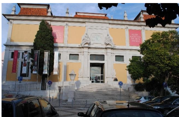
Figura 5.6: Fachada a poente – zona do anexo.
