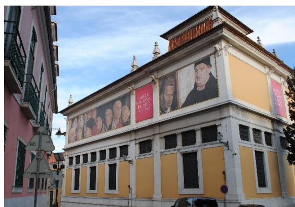
Figura 5.9: Fachada norte – zona do anexo.
