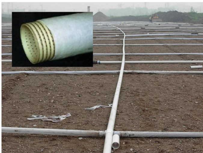
Figura 2.4 - Ligação dos drenos verticais ao sistema de drenagem horizontal; adaptado de Quynh e Tian, (2009).
