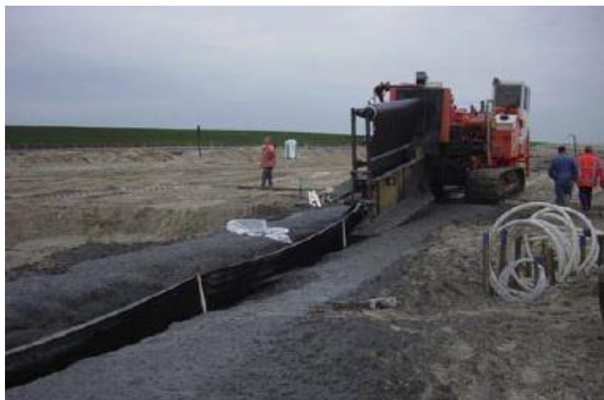
Figura 4.10 – Execução de uma parede de confinamento lateral; Varaksin, (2016).
