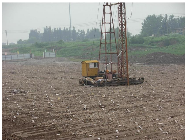
Figura 2.3 - Colocação dos drenos no terreno com o mandril; adaptado de Quynh e Tian, (2009).
