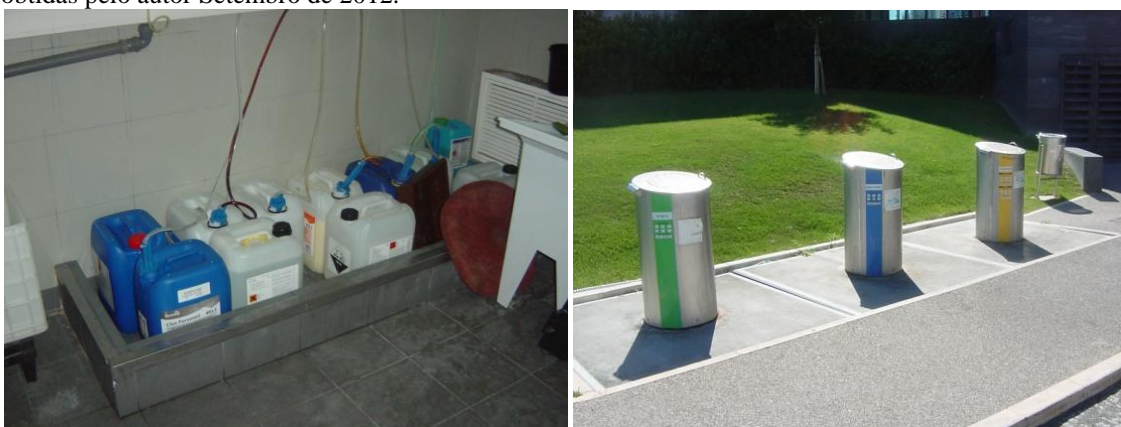
Figura 6.16 - Armazenamento em bacia de retenção para produtos tóxicos (esquerda) e contentores para cada tipologia de resíduo (direita). Fotos obtidas pelo autor Setembro de 2012.
