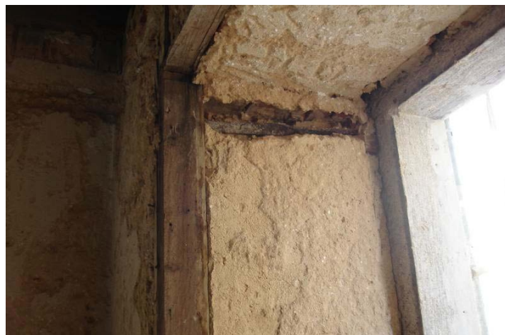
Figura 51 - Solidarização da gaiola com as cantarias através de gatos metálicos
