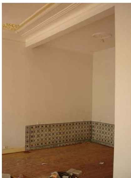
Figura 65 - Substituição de frontal por viga
