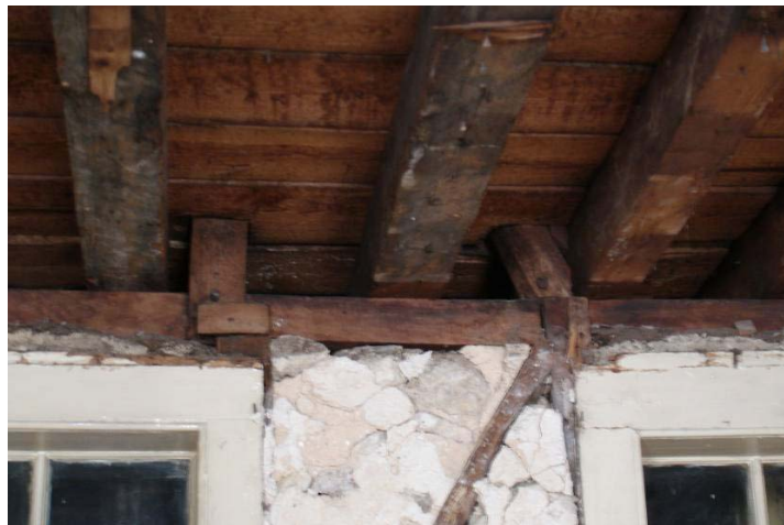
Figura 26 - Parede exterior - Rua da Misericórdia
