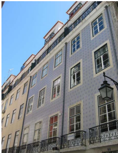
Figura 64 - Alteração do revestimento exterior de um edifício Pombalino para azulejos
