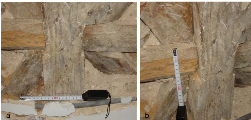
Figura 29 - Dimensões dos elementos das cruzes de Santo André: a) prumos com aproximadamente 10 cm; b) travessanhos com aproximadamente 8 cm
