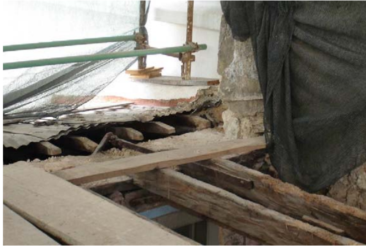
Figura 47 - Ligaç o das vigas   parede de fachada atrav s de gatos met licos
