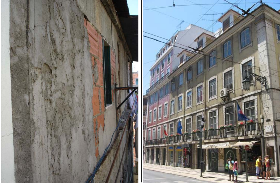
Figura 68 - Acréscimo de um piso em altura em alvenaria de tijolo
