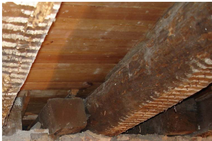
Figura 48 - Vigas de pavimento com marcas do fasquiado do tecto
