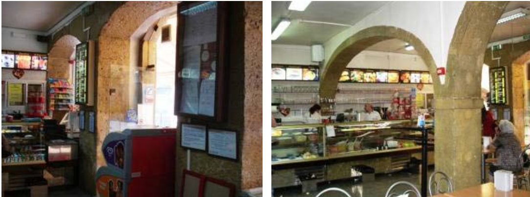
Figura 24 - Fotografias de piso térreo de um edifício Pombalino – Rua dos Correiros
