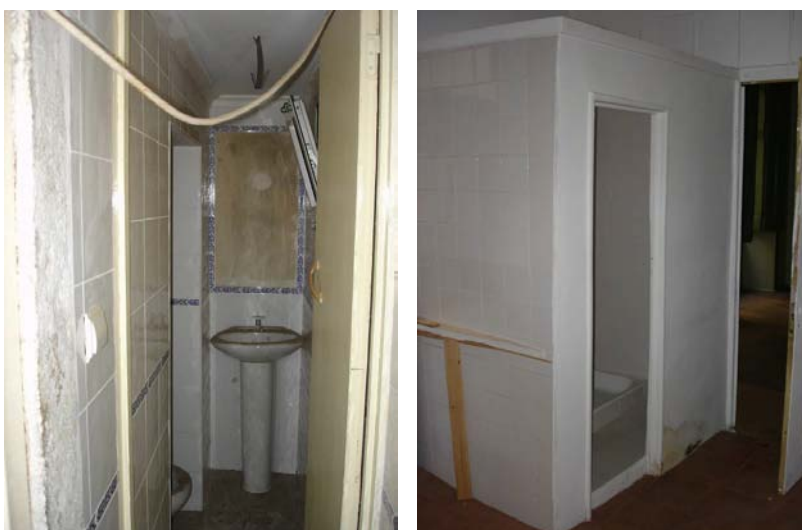
Figura 70 - Acrescento de instalações sanitárias: a) na parede de fachada do saguão; b) Levantamento de paredes em alvenaria de tijolo
