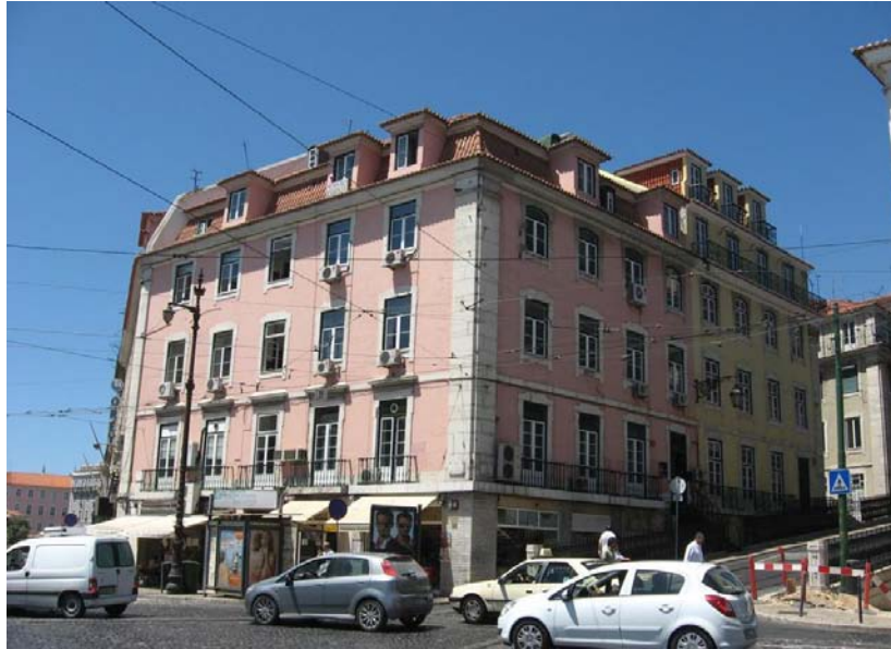
Figura 41 - Edifício com cobertura em mansarda
