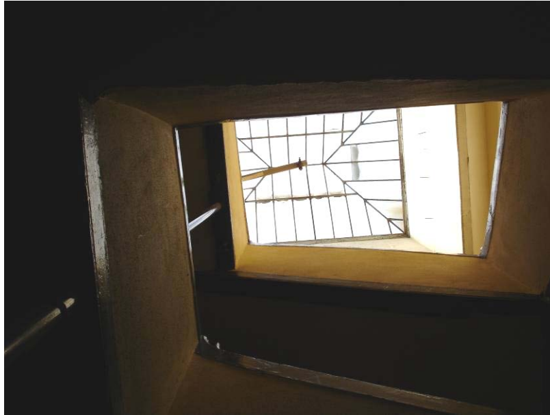
Figura 42 - Clarabóia para iluminação da caixa de escadas
