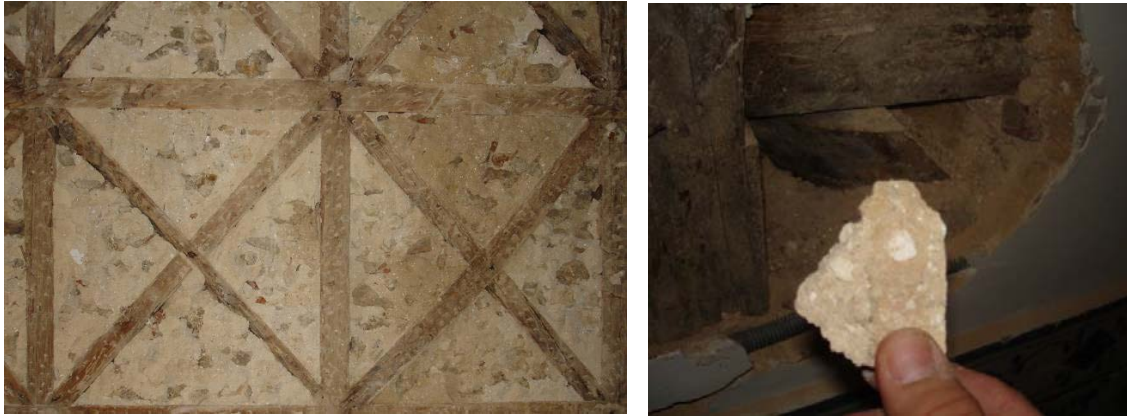
Figura 30 - Frontal preenchido com argamassa de cal, pequenas pedras e elementos cerâmicos
