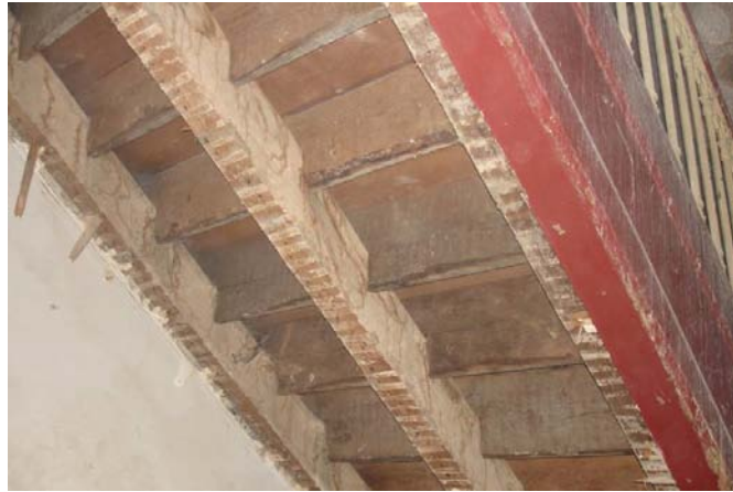
Figura 33 - Apoio dos degraus nas pernas do lanço de escadas
