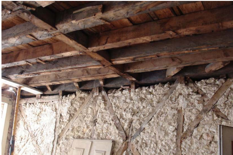
Figura 43 - Vigamento do pavimento
