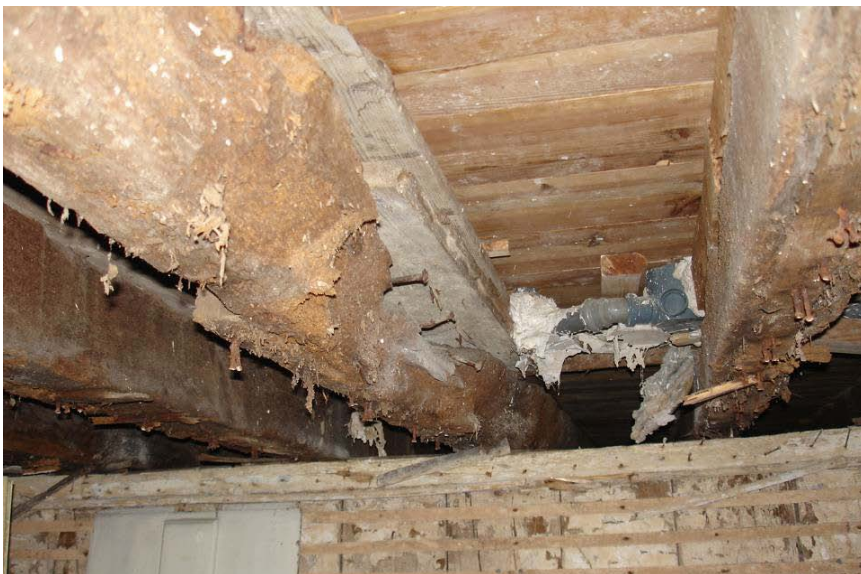
Figura 66 - Corte parcial das vigas de pavimento para a instalação de rede de águas
