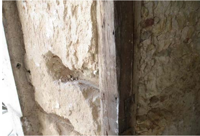
Figura 27 - Gatos metálicos de solidarização da estrutura da gaiola com o paramento exterior - Rua da Misericórdia
