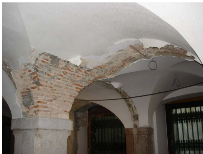
Figura 16 - Abóbadas trabalhadas em alvenaria de tijoleira
