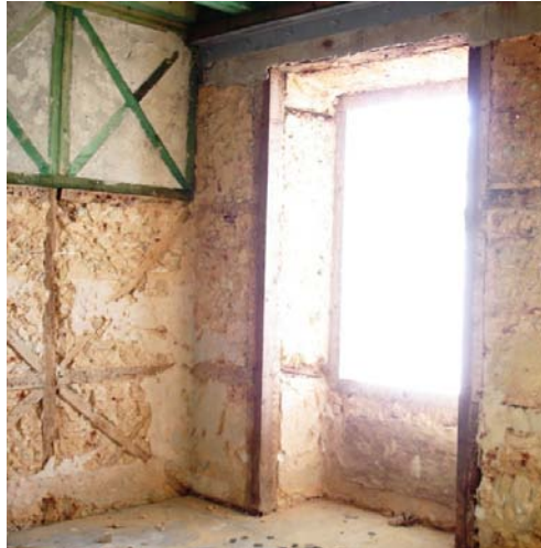
Figura 17 - Paredes em alvenaria de pedra ligadas à "gaiola" 1
