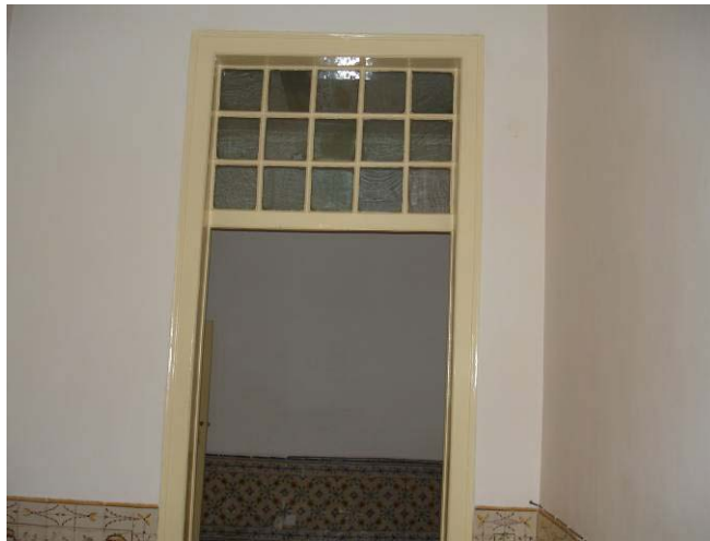
Figura 52 - Bandeira com vidros em vão interior
