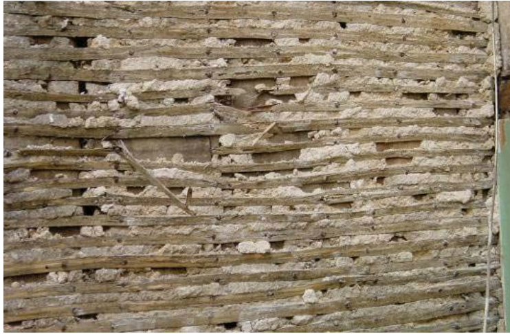
Figura 31 – Fotografia de parede de tabique – Edifício em Alfama
