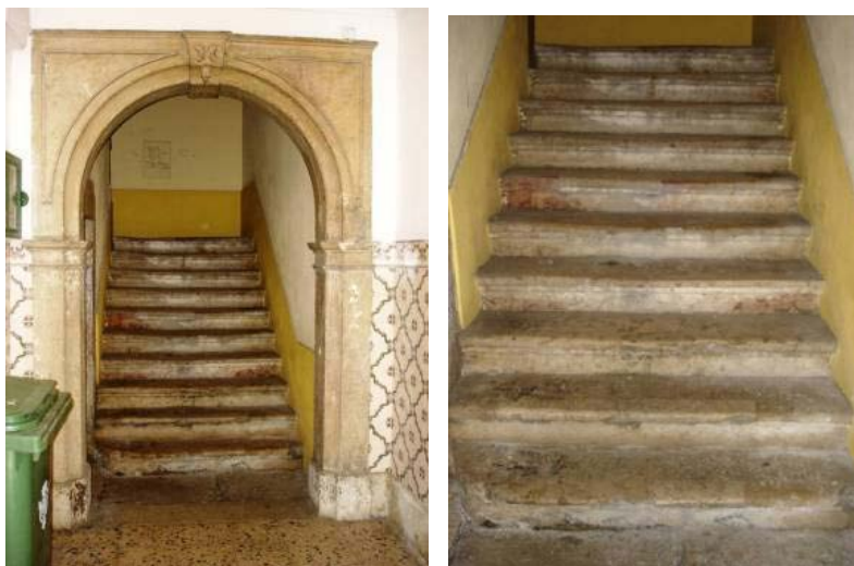
Figura 32 – Fotografias das escadas no piso térreo de um edifício Pombalino – Rua dos Correeiros
