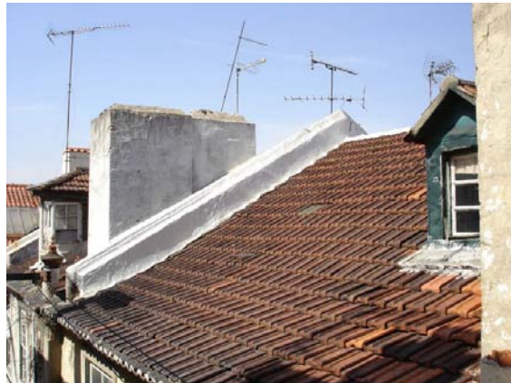
Figura 59 - Chaminé vista pelo exterior
