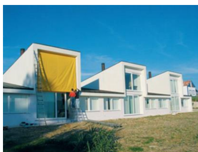
Figura 3.47 Casas de Janas, com os seus envidraçados orientados a sul e exemplo de sombreamento (Gonçalves e Graça, 2004)
