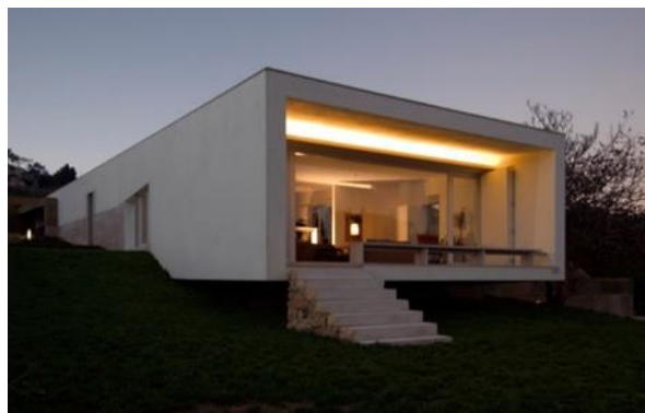
Figura 3.49: Habitação passiva em Romeirão (Archdaily, sem data)
