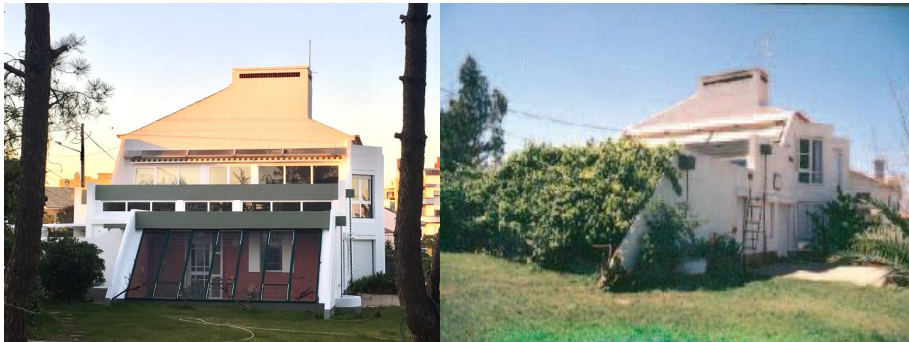
Figura 3.19: Moradia unifamiliar com estufa, à esquerda em situação de inverno e à direita em situação de verão, com proteção de vegetação (Gonçalves e Graça, 2004)
