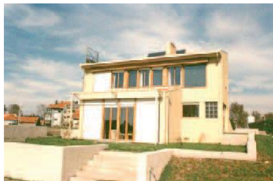
Figura 3.41: Casa Termicamente Otimizada, no Porto (Gonçalves e Graça, 2004)
