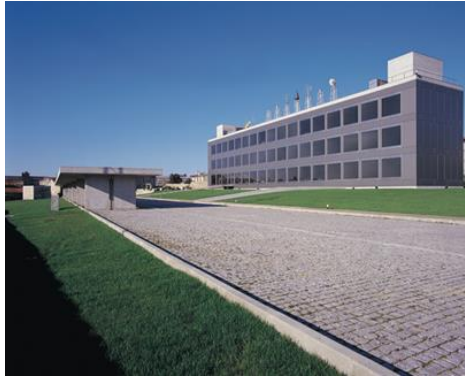
Figura 3.15: Envidraçados orientados a sul no edifício de serviços, ICP, no Porto (Ciamh, sem data)
