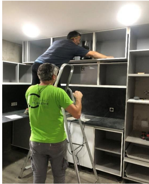
Figura 4.18 - Fixação dos módulos.
