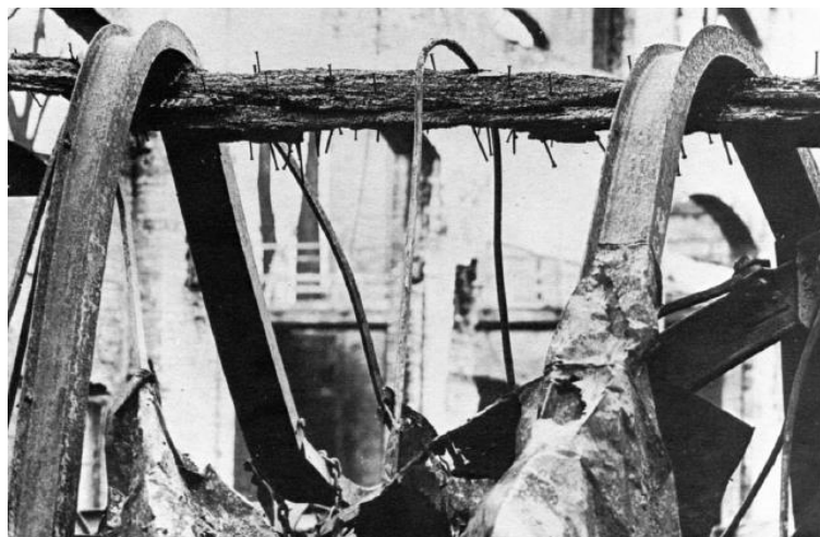
Figura 2.18 – Viga de madeira a segurar perfis metálicos depois de arder [50].
