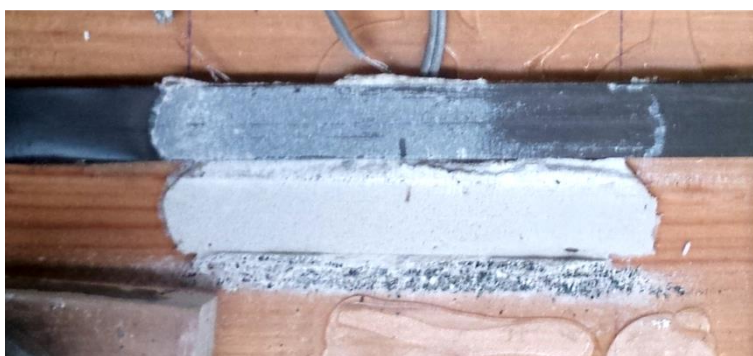
Figura 4.23 – Rotura do ensaio W_EBR_Lb65_02.
