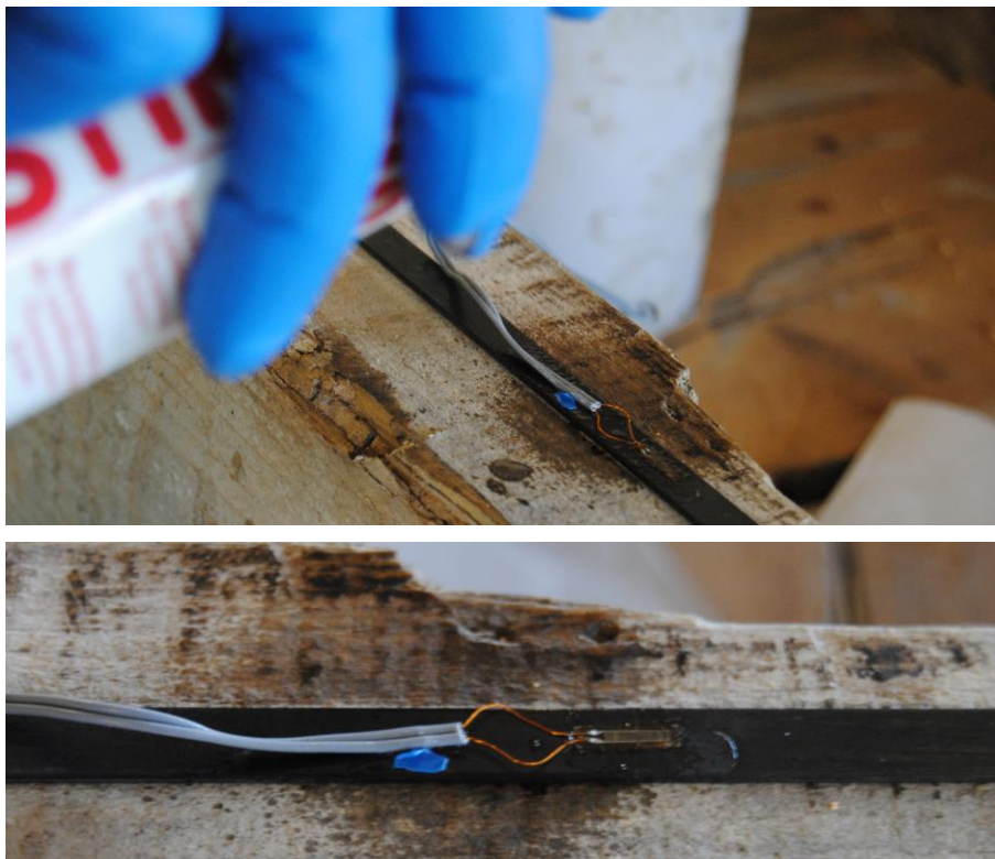
Figura 5.29 – Pormenor do spray isolante e aspeto final.
