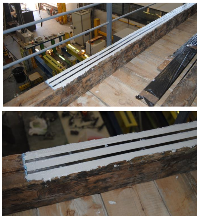
Figura 5.7 – Aspeto final da viga reforçada através de EBR.
