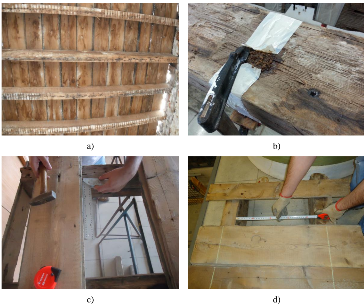
Figura 5.2 – a) Vigas em obra; b) Preenchimento dos nós; c) e d) Pregagem das tábuas.
