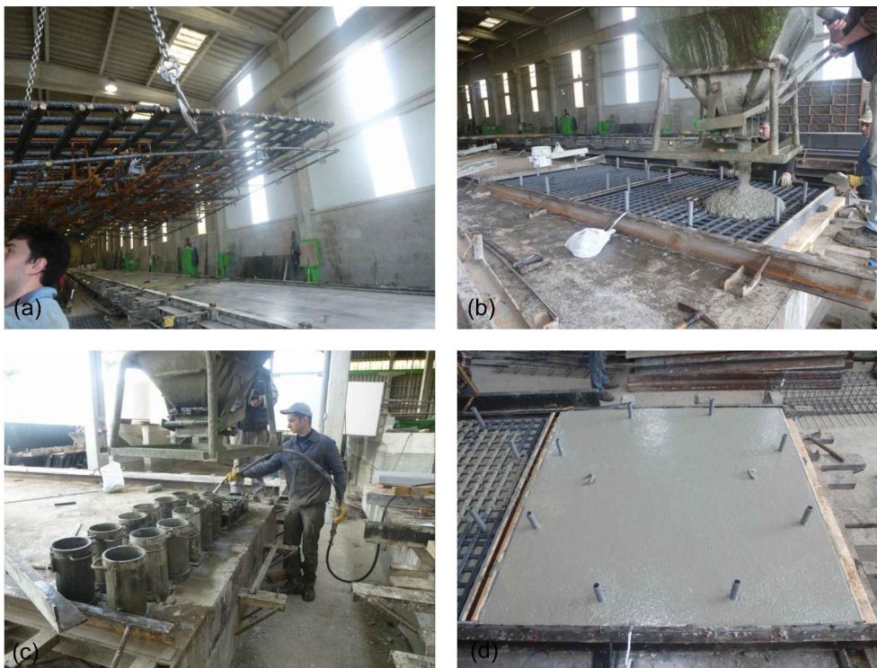
Figura 3.13: (a) Pormenor dos espaçadores em PVC; (b) Betonagem; (c) Recolha de amostras; (d) Aspeto de um modelo betonado.
