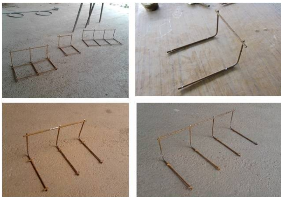
Figura 3.7: Fotografia dos estribos de ramos verticais.
