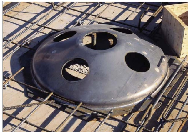
Figura 2.4: Novo sistema de armaduras "UFO" [2].
