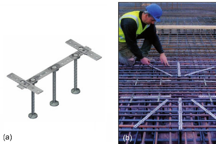
Figura 2.17: Sistema de armaduras de punção "Halfen HDB studs": (a) Elemento "Halfen HDB" típico; (b) Colocação em obra [35].
