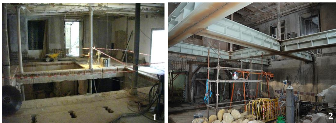
1 - Demolição parcial ainda com os pilares no piso zero; 2- Instalação das vigas metálica já sem pilares no piso zero.
