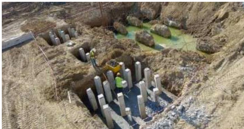
Figura 2.16 - Estacas cravadas - imagem da obra da EXEO no Parque das Nações
