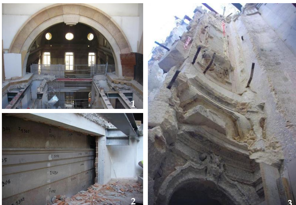
1 -Pormenor da estrutura metálica existente; 2 - Demolição cuidada no altar-mor; 3 - Pormenor da primitiva cabeceira do Altar-Mor
