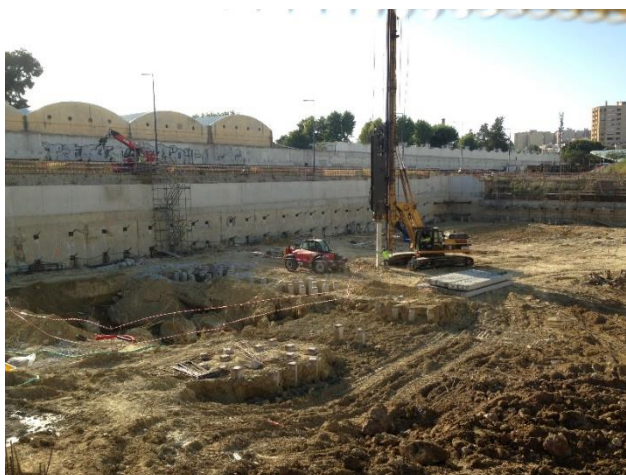
Figura 4.20 - Execução de estacas cravadas
