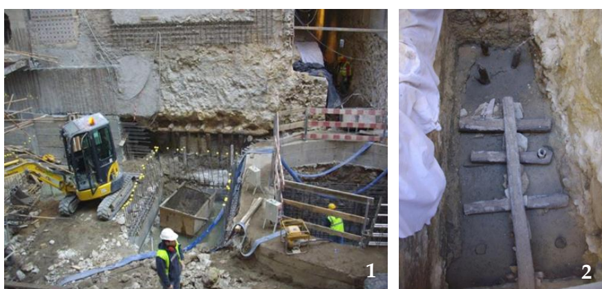
1-Vista da fundação da parede de separação entre a zona dos edifícios de sacrifício e a zona dos edifícios correntes; 2- Pormenor da fundação das paredes existentes
