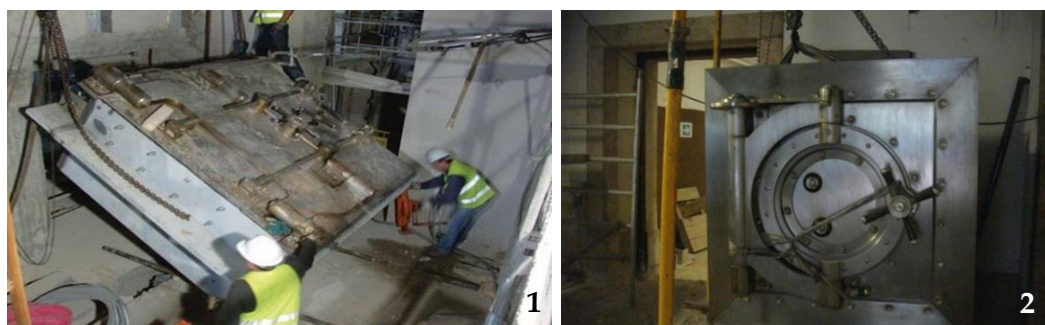
1 - Retirada da caixa-forte; 2 - Elevação da caixa-forte
