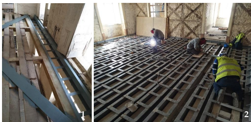
1-Exemplos de reforço com elementos metálicos sobre um teto artístico; 2-Reforço de pavimento por meio de chapas metálicas para introdução de aparelhos de ar condicionado.
