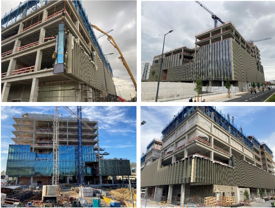
Figura 4.23 - Montagem da fachada de alumínio e vidro.
