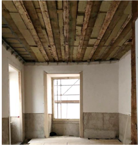
Figura 2.13 – Colocação de novas vigas paralelas às existentes na obra Ivens Arte.
