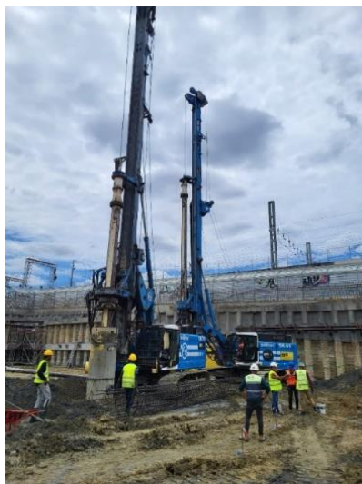
Figura 2.17 - Estacas moldadas - imagem da obra do lote 1.11 no Parque das Nações
