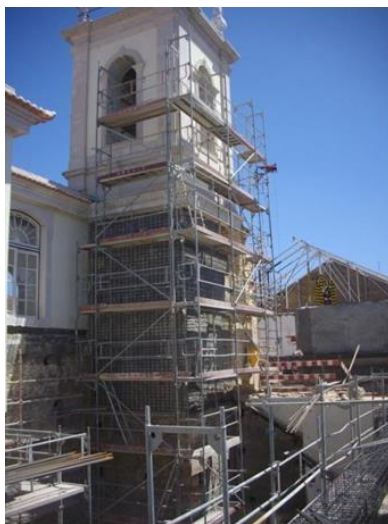
Figura 3.19 - Trabalhos de suspensão da torre sineira
