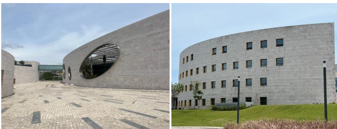
Figura 4.9 – Fachadas em cantaria dos edifícios do complexo.
