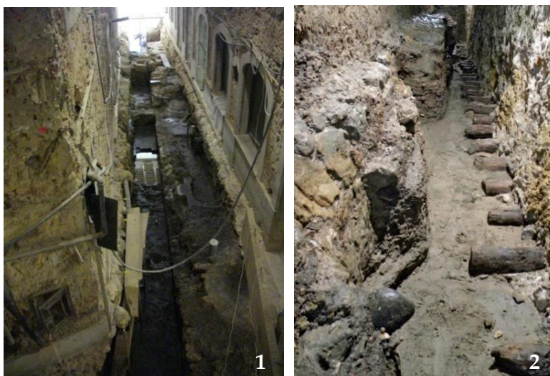
1 -Vista geral da zona do saguão; 2 - Pormenor da muralha e da fundação da parede do saguão
