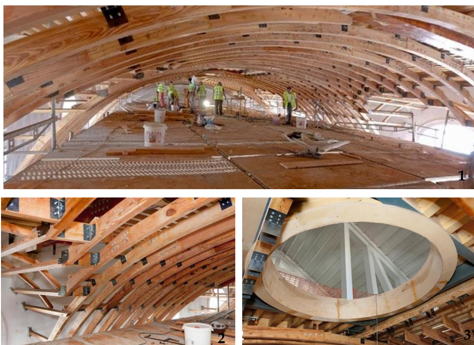
1 - Vista geral; 2 - Pormenores da fixação às paredes; 3 - Pormenor do óculo central Figura 3.23 - Execução da estrutura da madeira do novo teto falso da nave central
