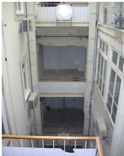
Figura 3.12 - Aspeto do saguão no início da intervenção
