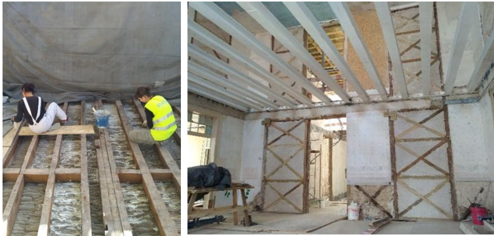
Figura 3.40 - Intervenção das técnicas de restauro em simultâneo com a fase de demolição
