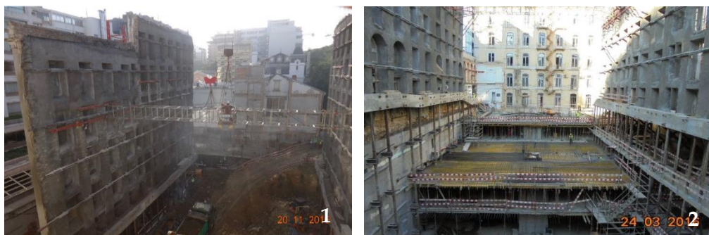
1 - Montagem da treliça metálica; 2 - execução da nova estrutura, onde pode ser visto o escoramento metálico
