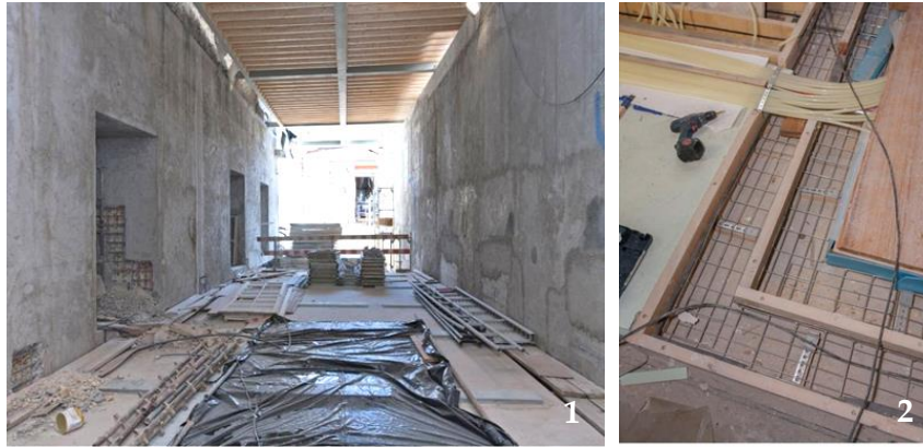
1 - Execução da estrutura de madeira dos pavimentos e tetos; 2- Pormenores das caleiras técnicas
