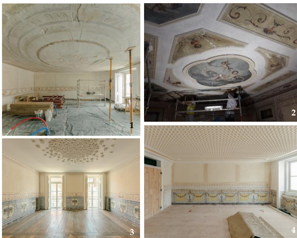
1 - Escoramento para recuperação; 2 - Restauro dos tetos artísticos existentes dos tetos artísticos existentes; 3 e 4 Execução de novos tetos artísticos em estafe e estuque
