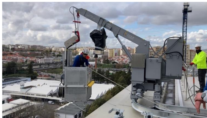
Figura 4.24 - Montagem do bailéu sobre o capeamento da fachada
