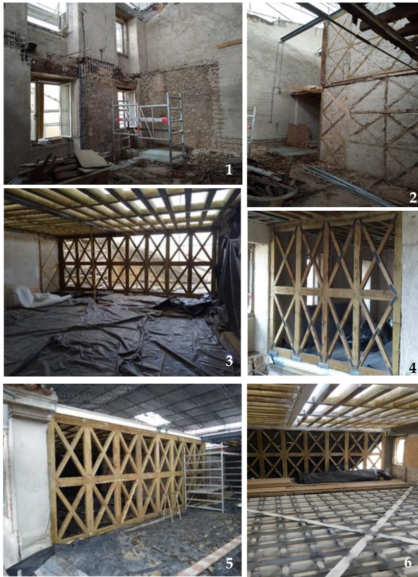
1 e 2 Laminas de compressão em paredes exteriores e interiores; 3,4 e 5 - Execução de novas paredes de frontal; 6 - Reforço de pavimento existente
