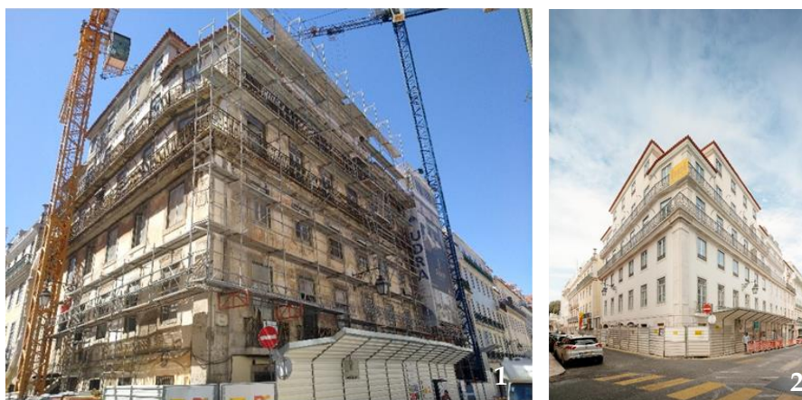
1 - Aspeto da obra no início da empreitada; 2 - Vista da obra já em fase final do gaveto da Rua Ivens com a Rua Capelo
