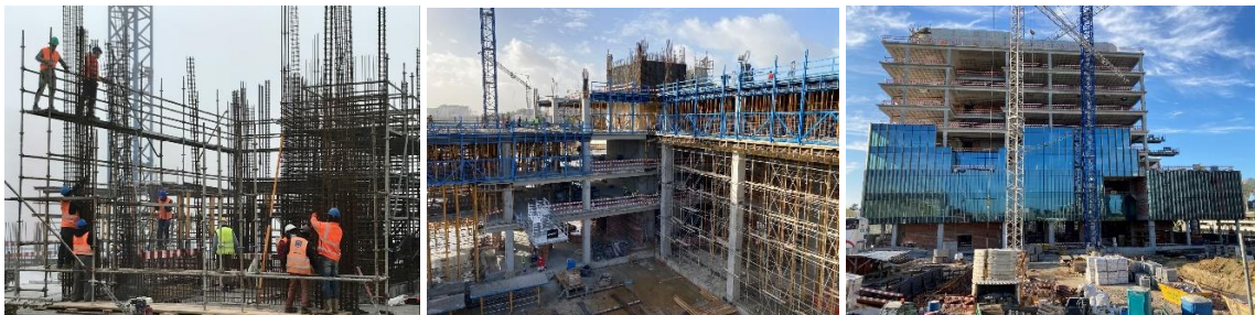
Figura 4.22 – Execução da superestrutura
