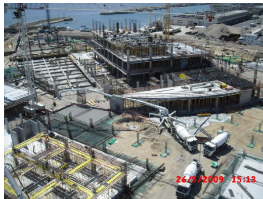
Figura 4.7 – Fase de estrutura da obra de construção da Fundação Champalimaud
