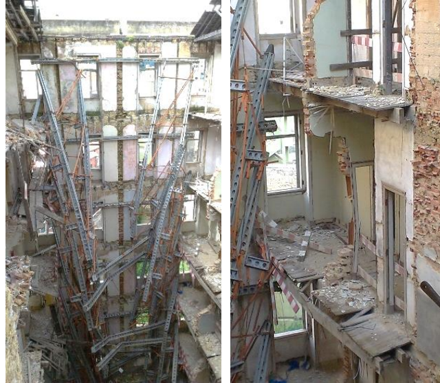
Figura 3.53 - Aspeto de uma zona do interior do edifício antes do início da obra
