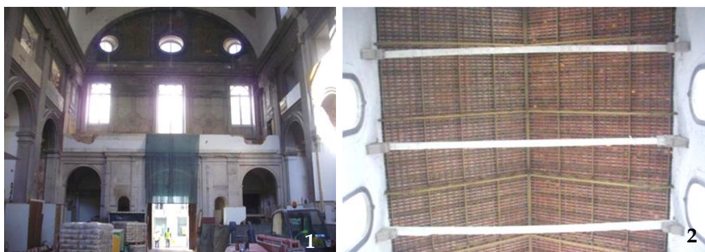
1 - Vista do coro alto no início de intervenção; 2 - Teto existente
