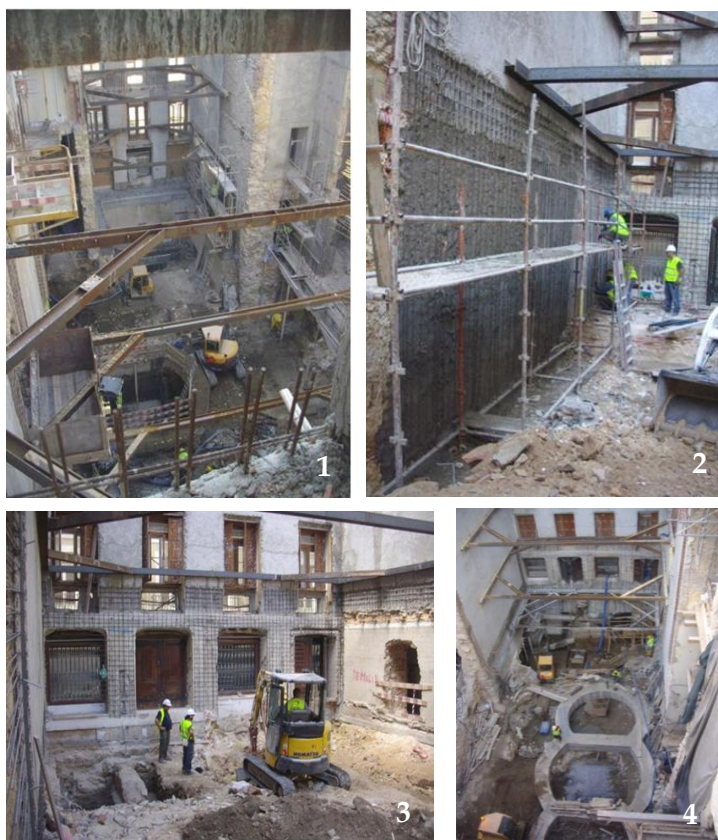
1 - Aspeto geral da zona após a demolição do interior dos edifícios; 2. Pormenor do escoramento e reforço das paredes existentes; 3. Início dos trabalhos de escavação; 4. Aspeto da zona após execução do jet-grouting
