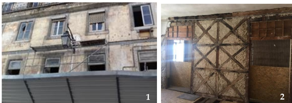
1 - Tirantes colocados no exterior; 2- Tirantes colocados no interior;
