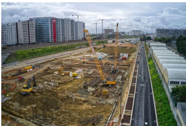
Figura 4.19 - Início dos trabalhos no Lote 2 em simultâneo com os arranjos exteriores
