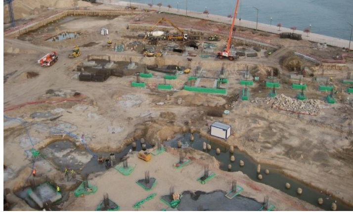
Figura 4.2 - Vista da obra no início da superestrutura
