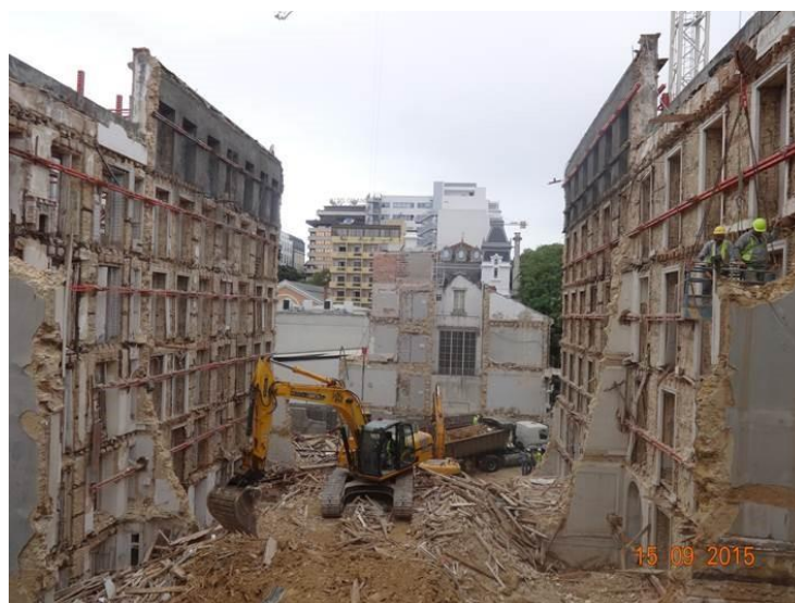
Figura 3.58 – Aspeto geral da obra após a demolição do interior dos edifícios da rua Rosa Araujo
