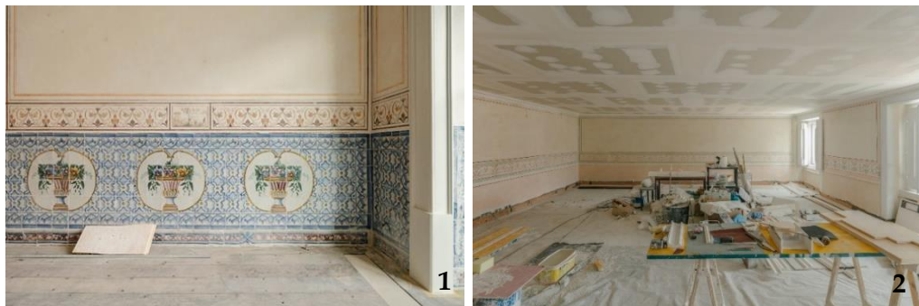
1 - Recolocação dos painéis de azulejo depois de terem sido restaurados; 2 - Execução das pinturas decorativas Figura 3.47 - Revestimento de paredes
