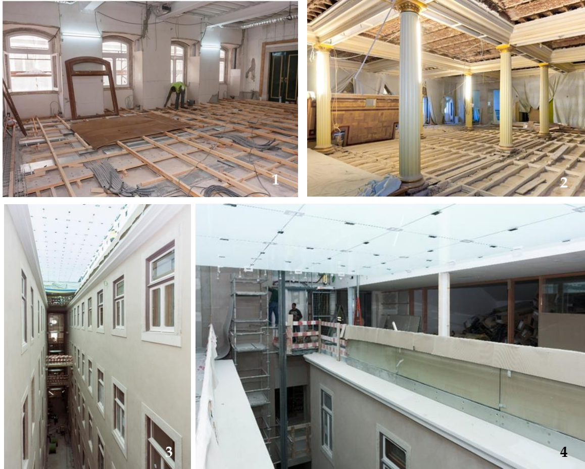
1 - Preparação dos novos pavimentos das salas; 2 - Execução de novos pavimentos e tetos 3 - Claraboia na zona do saguão; 4 - Pormenor da claraboia da nova zona de escritórios
