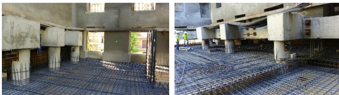
Figura 3.56 - Execução das lajes, junto à estrutura de suporte das paredes interiores.
