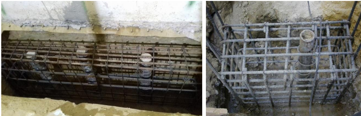
Figura 2.4 - Preparação das vigas de fundação que incorporam microestacas
