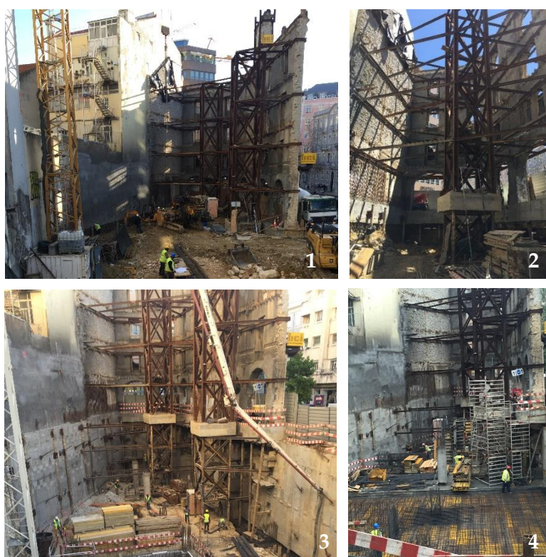
1 - Torres de contenção da fachada e da parede de tardoz antes do início da escavação; 2 - Pormenor da torre de escoramento apoiada no maciço suportado pelas microestacas; 3 - Vista das torres de escoramento no final da fase de contenção e escavação; 4 - execução das lajes de estacionamento
