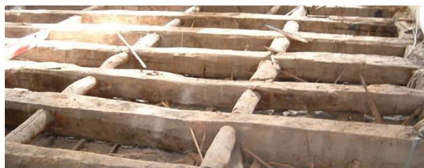
Fig. 2.39 - Vigamento e tarugos de um pavimento, Edifício São Domingos, séc. XIX (1856), Porto. (extraído de Dias, et al., 2008)
