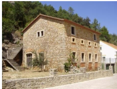
Fig. 2.1 - Edifício de alvenaria de pedra (em Agroal, concelho de Vila Nova de Ourém).
