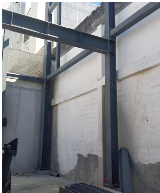
Figura 4.25 – Construção no espaço interior da nova estrutura metálica
