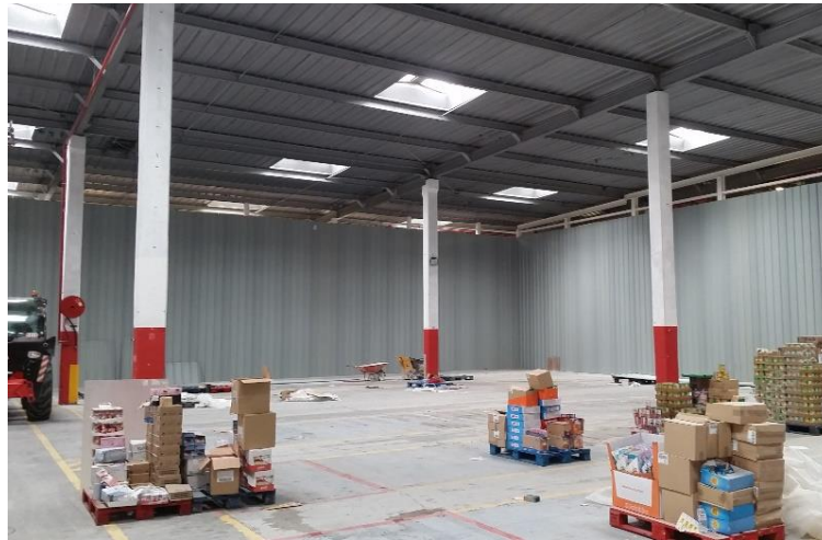
Figura 3.6 - Espaço interior do piso zero
