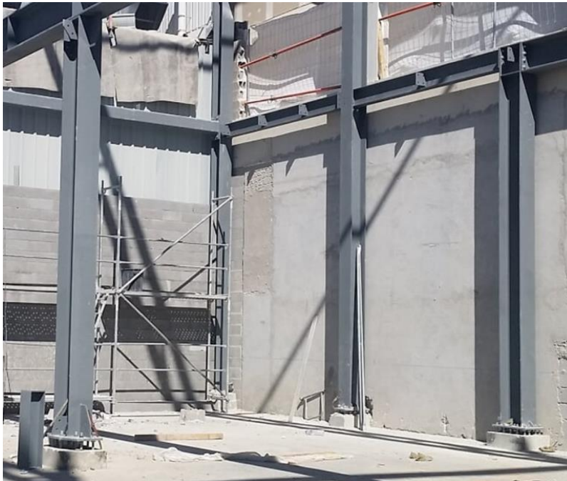
Figura 4.13 - Elevação da estrutura metálica de suporte às bancadas
