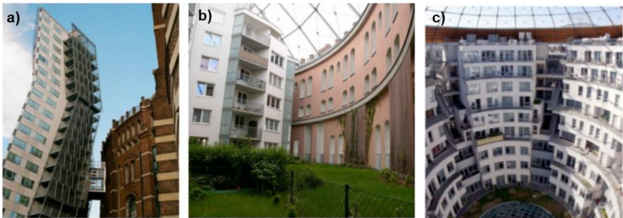
Figura 2.7 - Estado atual dos edifícios após reabilitação funcional; a) Reservatório B; b) Reservatório C; c) Reservatório D; (w5)
