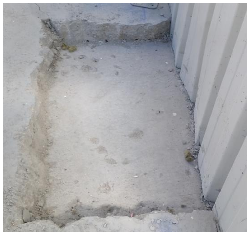
Figura 4.12 - Verificação em obra da diferença de cotas altimétricas
