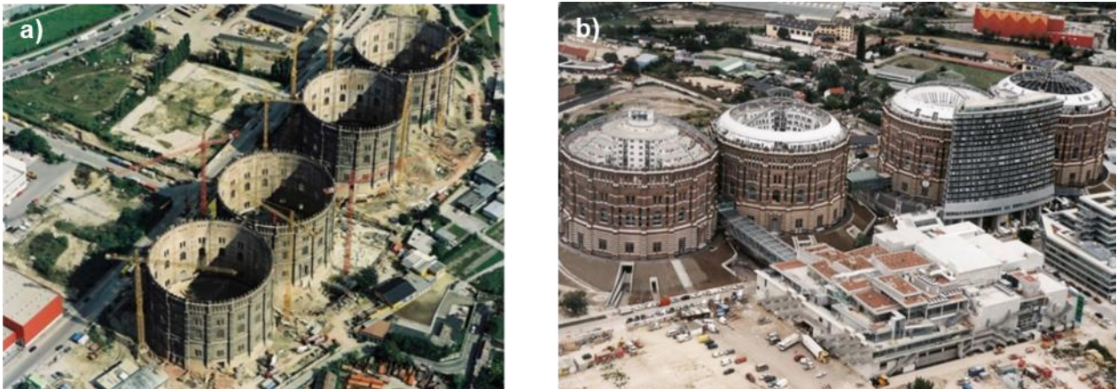
Figura 2.6 - Reabilitação funcional dos antigos reservatórios de gás. a) Fase inicial das obras de reabilitação; b) Aspeto final dos quatros edifícios após intervenção; (w5)
