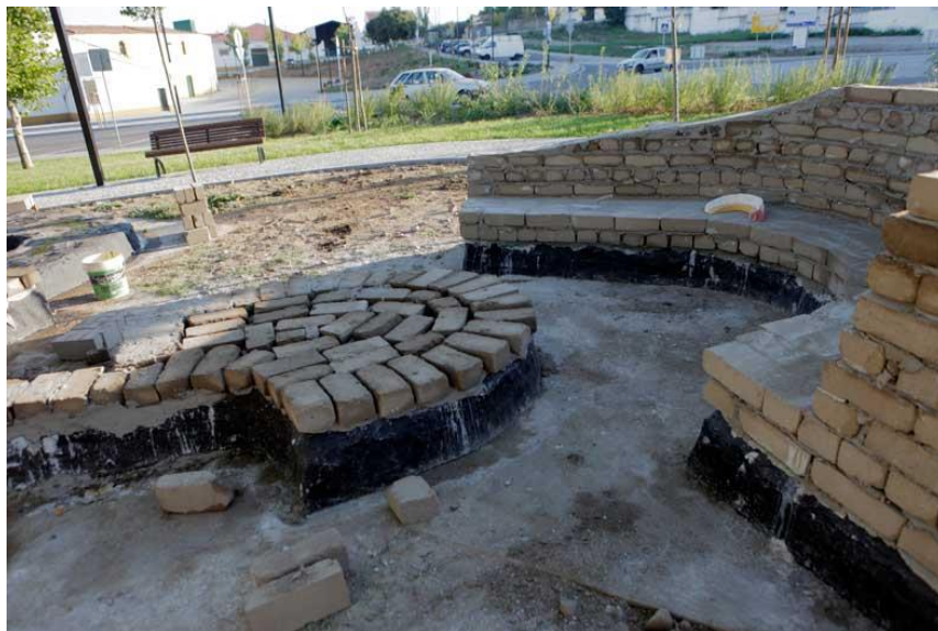
Figura 5.1 – Construção da alvenaria
