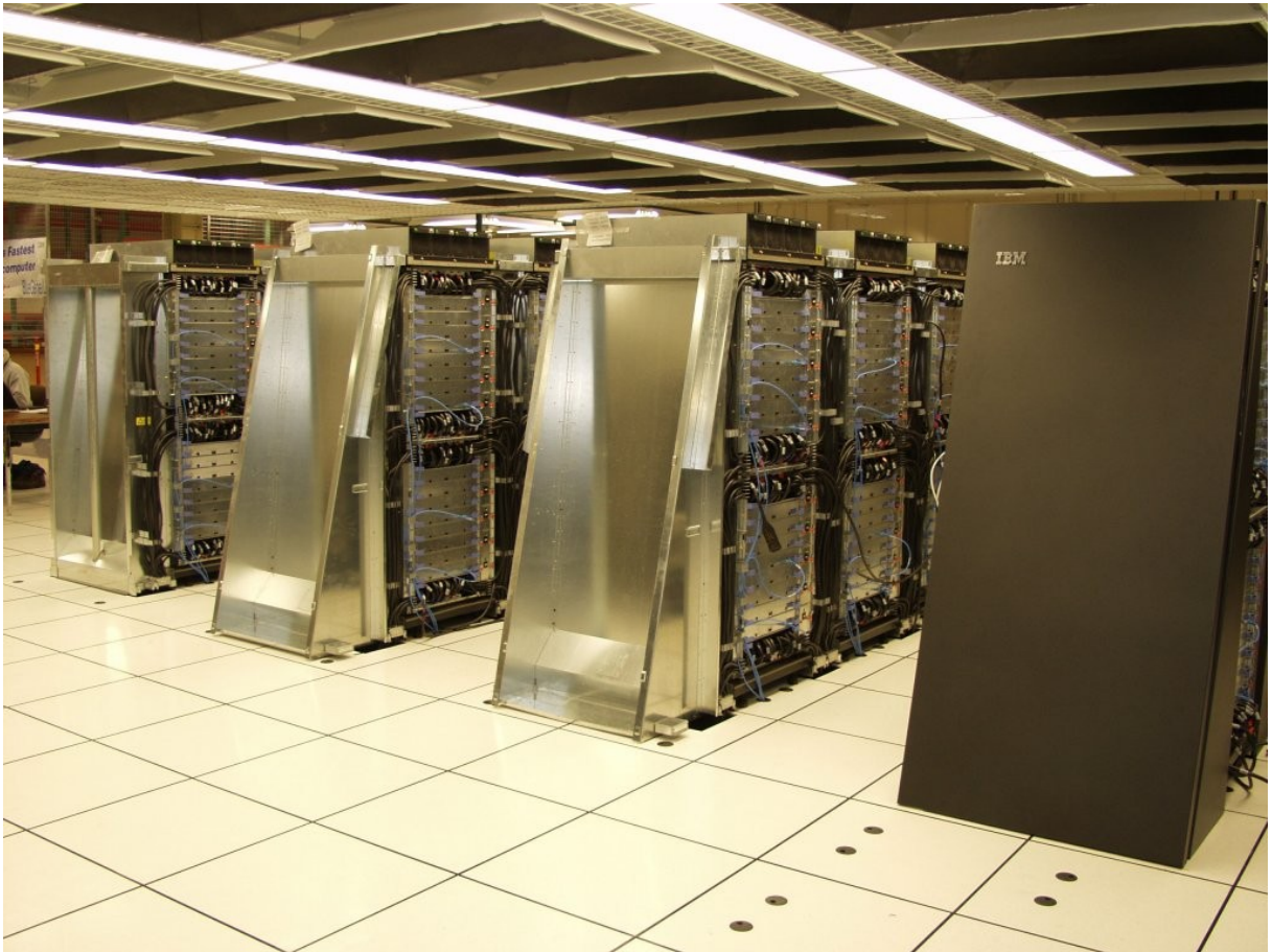
Figura 4: “BlueGene” em fase final de instalação
