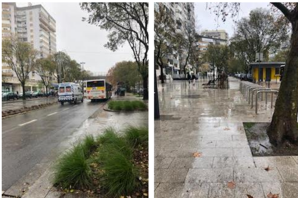
Figura 27 - Alameda das Linhas de Torres, pós intervenção
