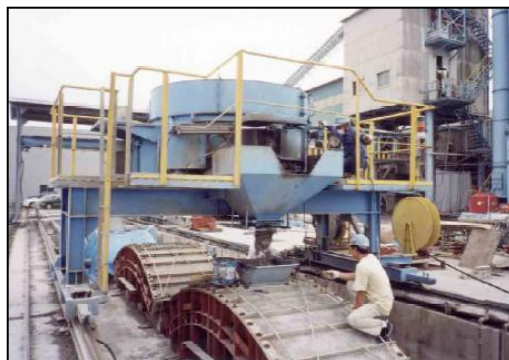
FIGURA 3 – PROCESSO DE BETONAGEM DE ADUELAS PRÉ-FABRICADAS (OKAMURA E OUCHI, 2003)
