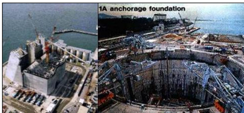
FIGURA 1 – UTILIZAÇÃO DO BAC NA CONSTRUÇÃO DA PONTE DE AKASHI-KAIKYO
