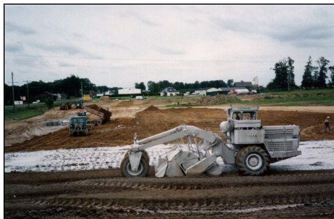
Figura 1.1– Veículo munido com equipamento de mistura (cortesia de Lusical, S. A.)
