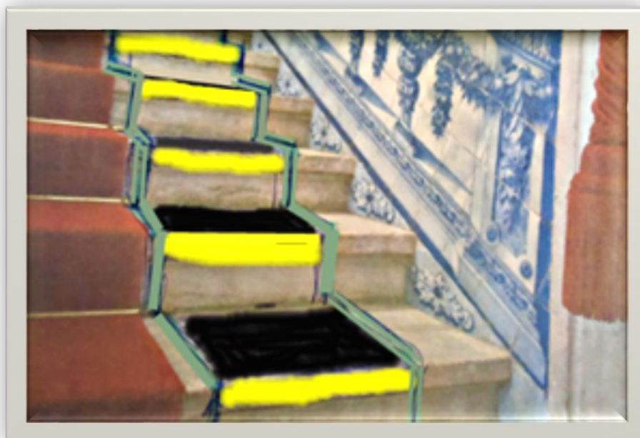
Imagens CLIV e CLV. Protótipo de passadeira para visitantes com mobilidade reduzida.
