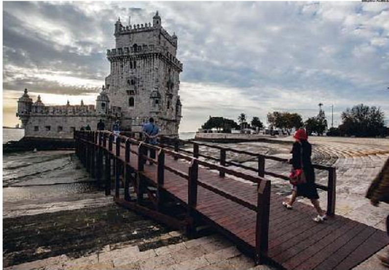
Infra-estrutura é feita de madeira azobé, adequada às condições no local
