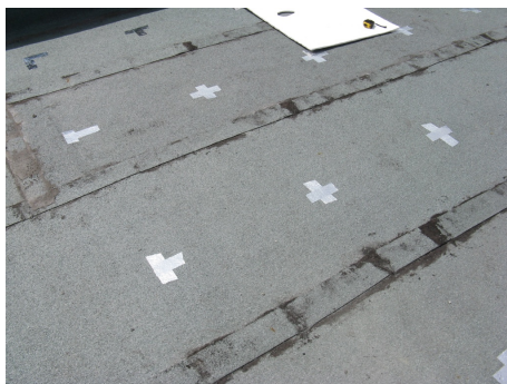
Fig. 5.27: Colocação da fita de alumínio adesiva para delimitação dos rectângulos da grelha.
