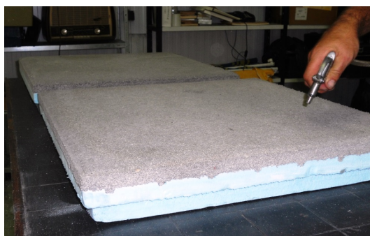
Fig. 5.18: Limpeza da superfície das lajetas com jacto de ar antes da aplicação das membranas de impermeabilização.
