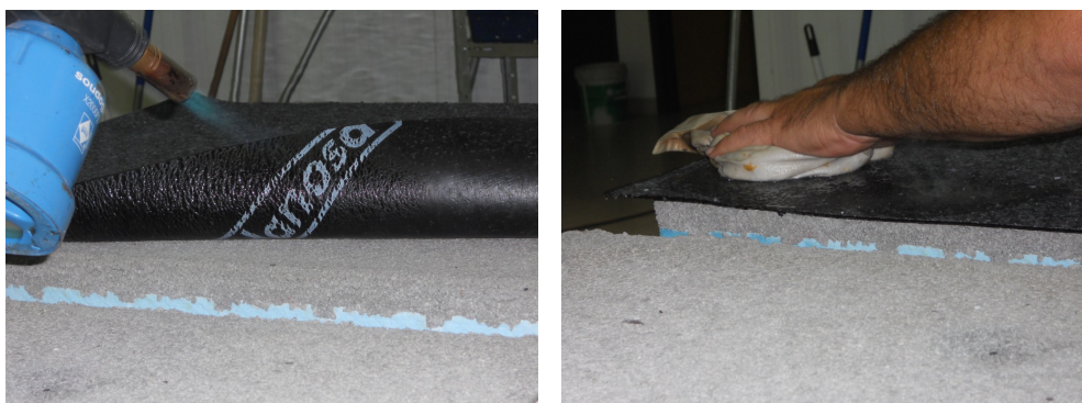
(a) Aplicação da membrana por soldadura através de chama. (b) Arrefecimento da membrana aplicada através da utilização de um pano molhado.
