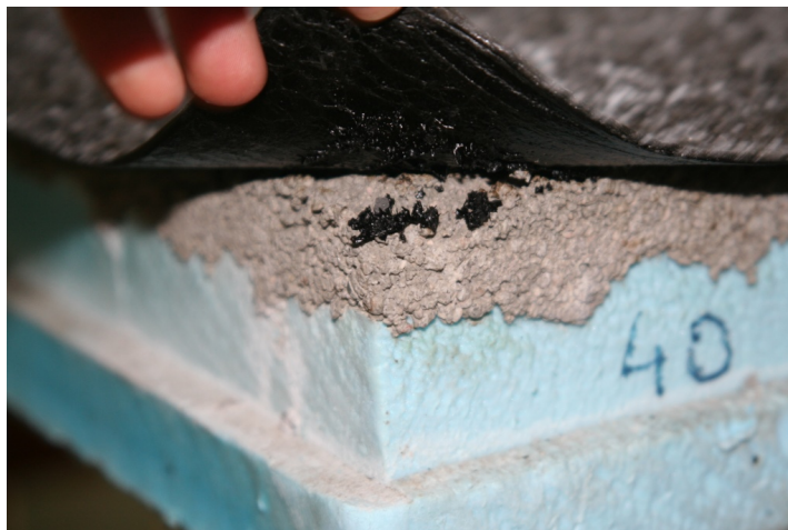
Fig. 6.44: Descolamento da membrana de impermeabilização junto ao canto superior direito do provete ensaiado.
