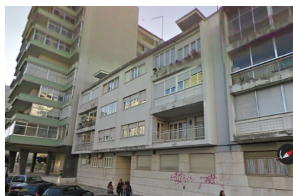
(b) Fachada principal do edifício.
