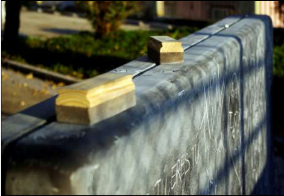
Figura 3.4 – Vista da parte superior da parede de giz em pormenor.
