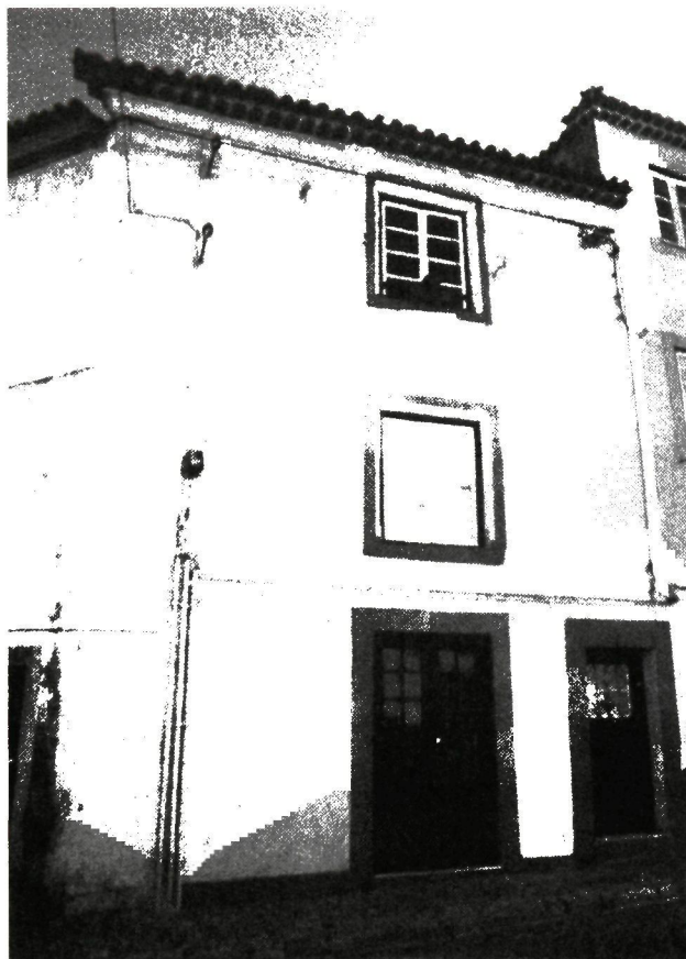
Fig. 5 – Aspecto geral do exterior.
