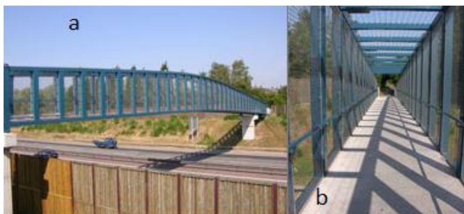
Figura 2.11 - Ponte pedonal em Broomhill, concebida com viga Vierendeel, no Reino Unido [31].
