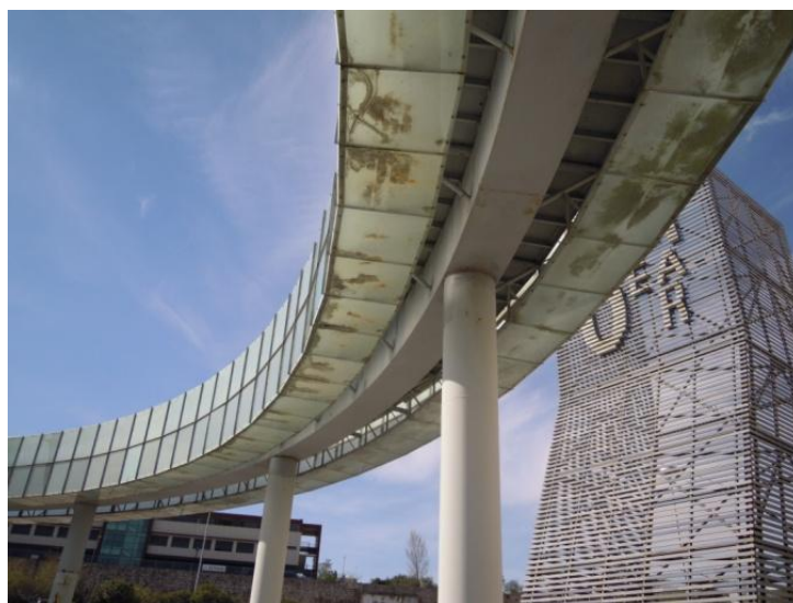
Figura 2.3 – Passadiço metálico curvo, com secção em caixão, no Parque das Nações, em Lisboa.
