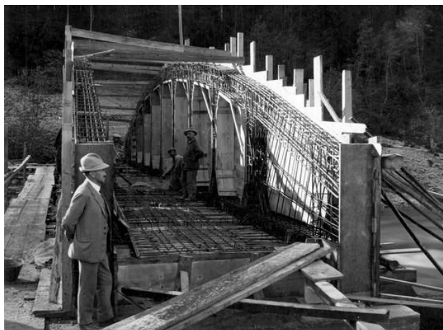
Figura 2.8 - Construção de uma ponte concebida com viga Vierendeel, em betão armado [30].
