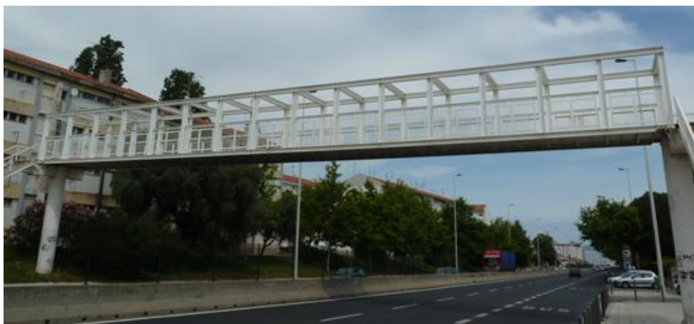
Figura 2.14 – Ponte pedonal com tabuleiro concebido com viga Vierendeel, situada na Av. Marechal Gomes da Costa, em Lisboa.
