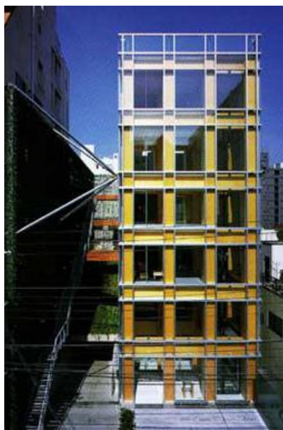
Figura 2.12 - Edifício concebido em estrutura metálica.
