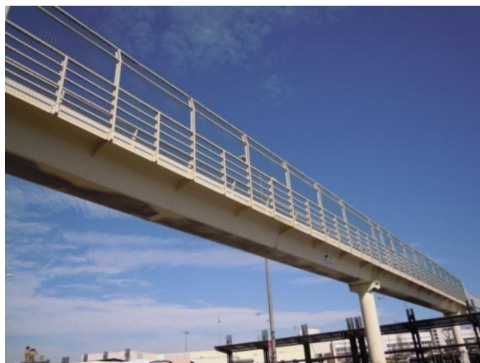
Figura 2.4 - Passadiço metálico com viga caixão com geometria trapezoidal, em Lisboa.
