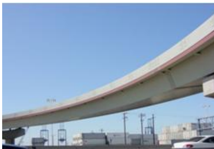
Figura 2.1 - Ponte curva em betão armado e pré-esforçado [26].
