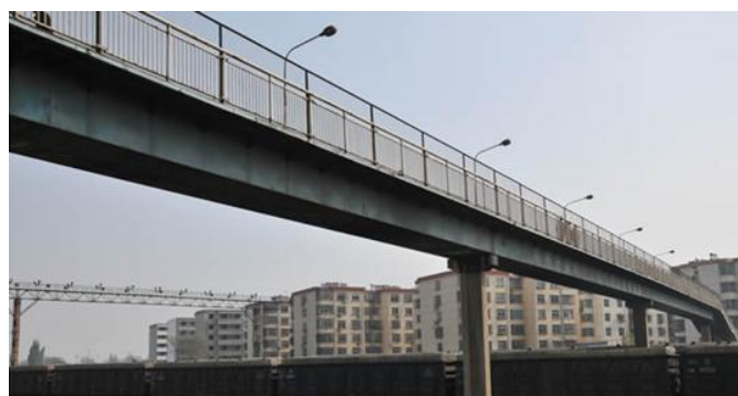
Figura 2.2 – Ponte na estação de comboios de Linfen, Xangai, com tabuleiro concebido com viga caixão [27].
