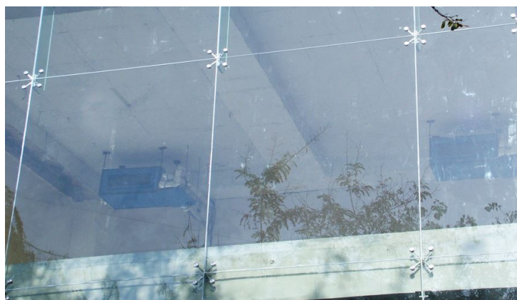
Fig. 2.13: Pormenor de uma fachada de vidro exterior agrafado [60]
