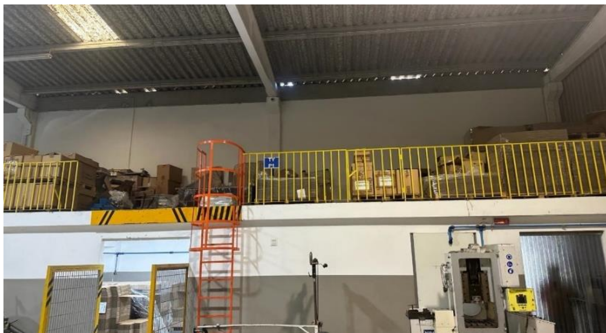
Figura 16 - armazém subaproveitado visto do piso 0
